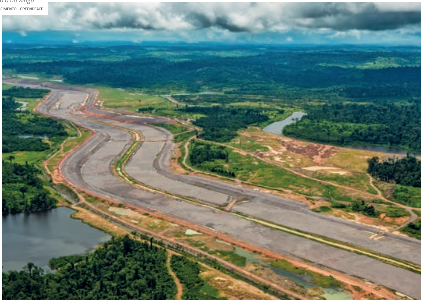
Construção do canal de 20 km de comprimento que desviará o rio Xingu FOTO: © FÁBIO NASCIMENTO - GREENPEACE
