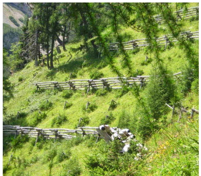
Holzschneebrücken und Aufforstungen Vordernberger Mauern, Mgde. Vordernberg
