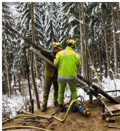
Errichtung eines Bohranchors für die Stein- schlagverbauung Oberweg, Stgde. Judenburg
