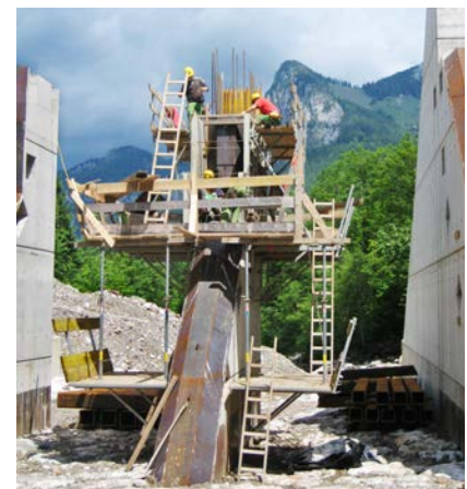
Errichtung Filtersperre Radmerbach, Gde. Radmer
