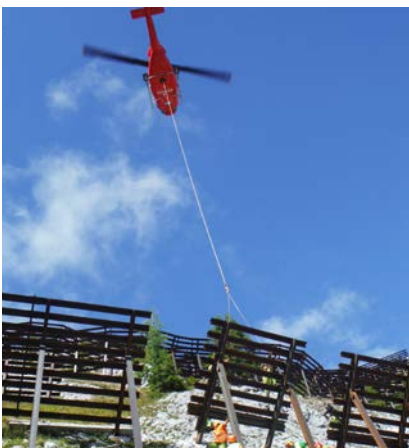
Einfliegen von Stahlschneebrücken Schoberwieslawinen, Gde. Grundlsee
