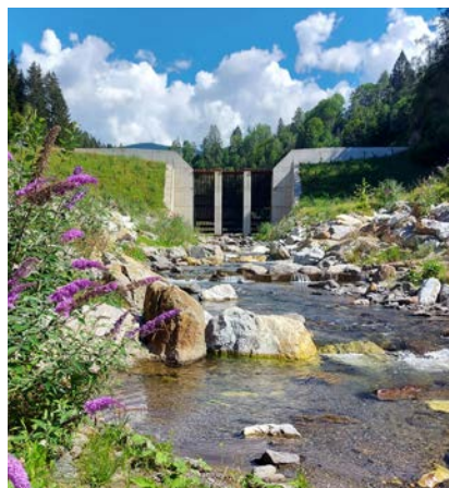
Filtersperre Schöttlbach, Stgde. Oberwölz
