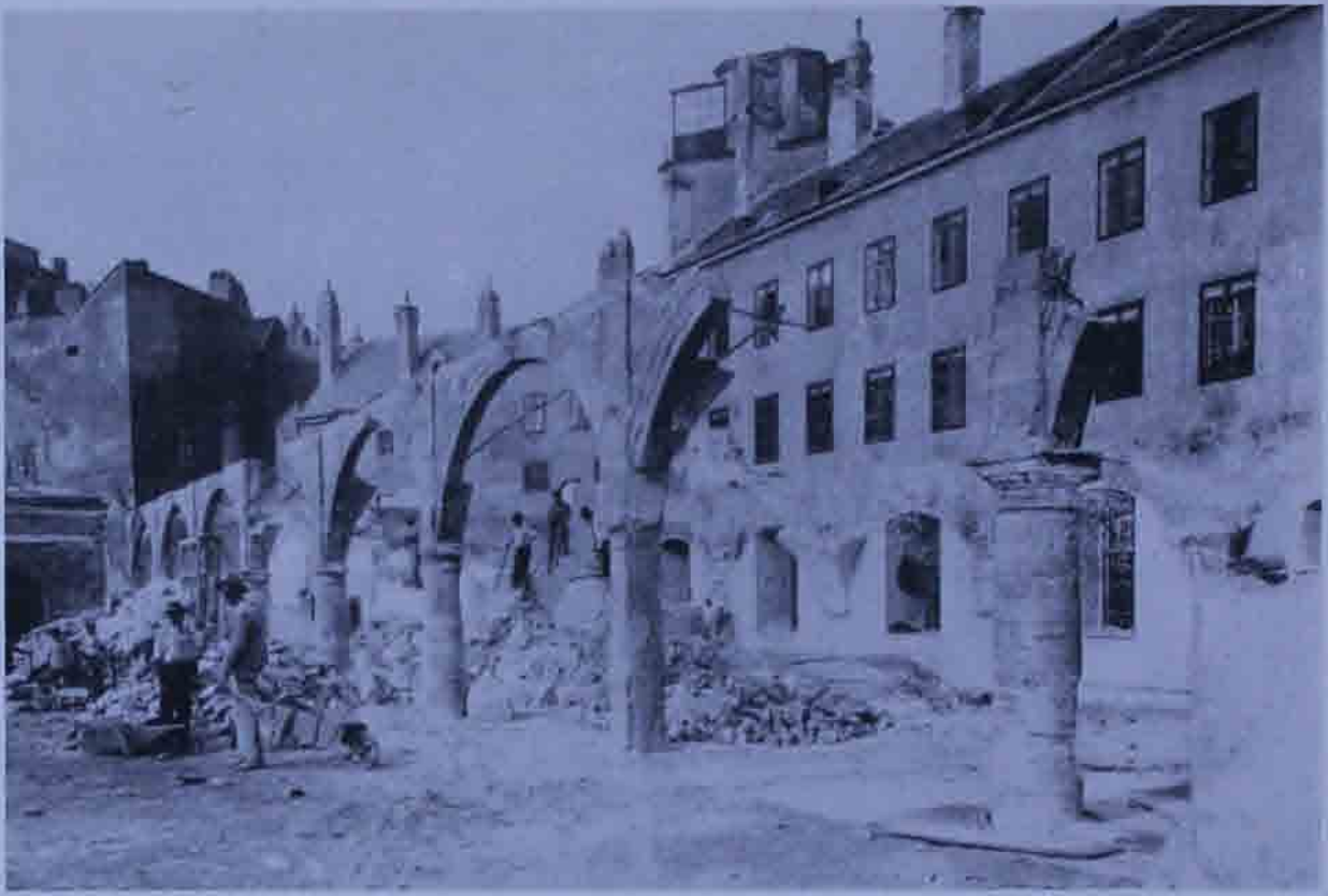
Abb. 3. Freigelegte Arkaden vor dem Haupttrakt des Hofspitals, Bildarchiv der NB.
