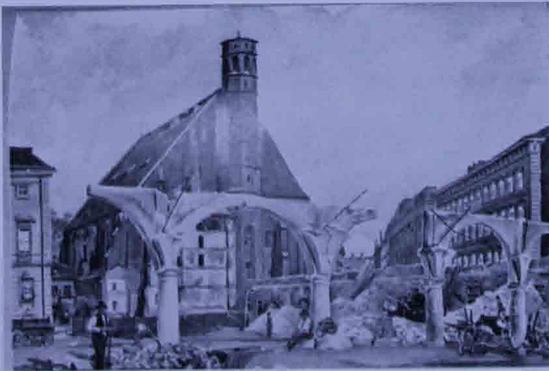
Abb. 2. Kaiserspital im Abbruch, nach einem Aquarell von 1903, Foto: Abmayer.
