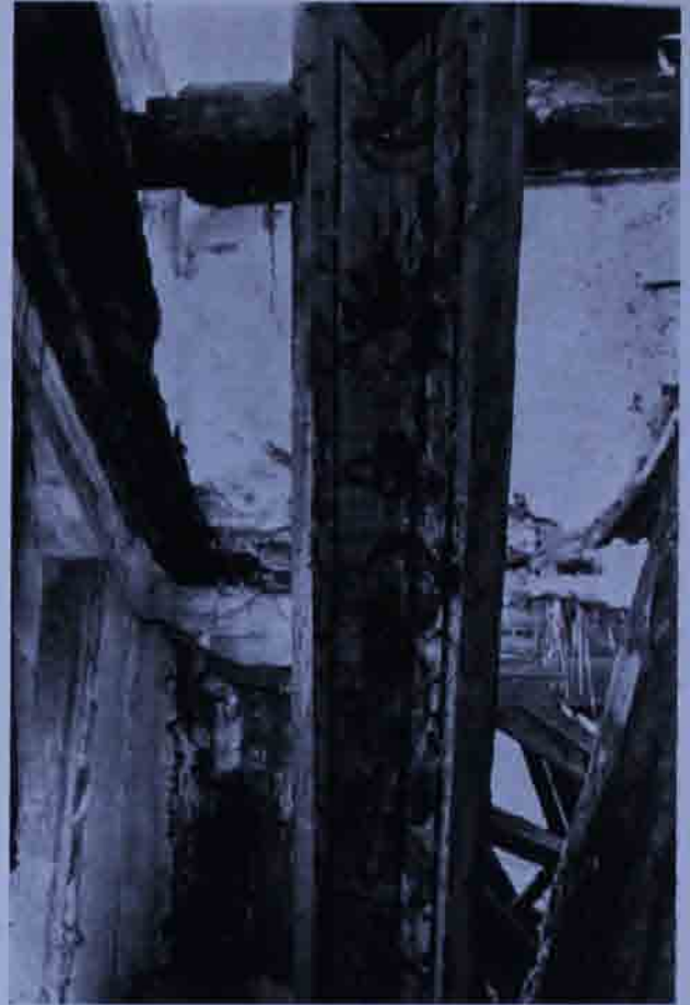
Abb. 6. 1965: Nord-Trakt, bemalter Holzdeckentram unter der ehem. kassierten Renaissancestuckdecke im 3. Geschöß [R 322] aus dem ehem. mittelalterlichen Palas. 1967: vernichtet.
