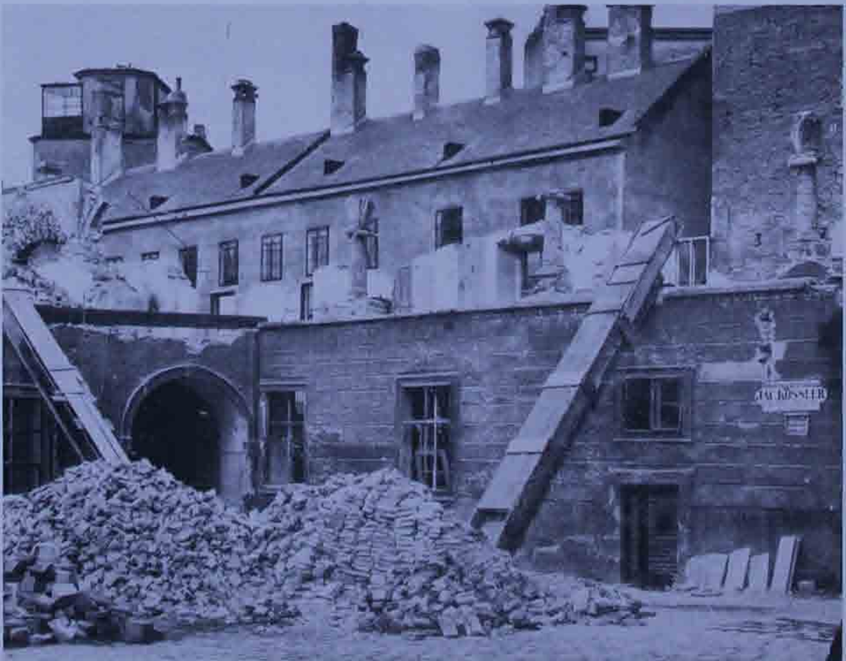
Abb. 4. Abbruch der oberen Arkaden, untere Reihe noch vermauert, Bildarchiv der NB.
