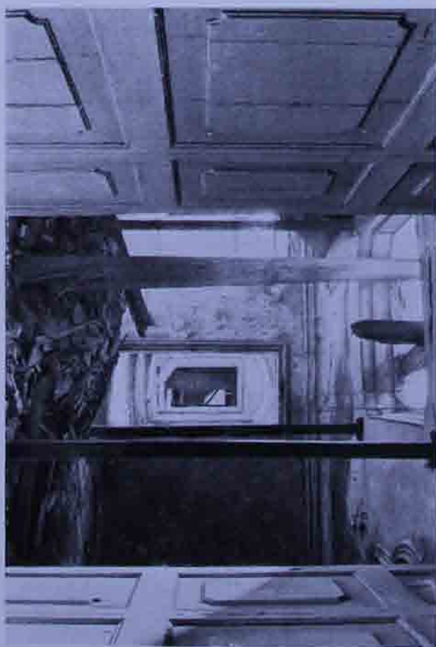
Abb. 3. 1963: Nord-Trakt. Raum m. quadratischer Deckenöffnung [R 221], 2. Geschöß, Durchblick in das Weststiegenhaus.
