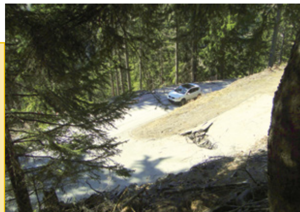
Abb. 1: Straßenschaden aufgrund eines einzelnen Sturzblockes ( 6\text{m}^3 ) eines kleinen Felssturzereignisses (1a) am 5. März 2012; Schäden infolge des Einzelabsturzes eines kompetenten Blocks von 250\text{m}^3 am 22.1. 2012 (Melzner, 2012) (1b).
