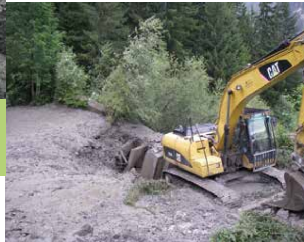
Abb. 19: Wasserseitiger Zufahrtsweg zur Räumung des funktionellen Teils mit schwerem Gerät
