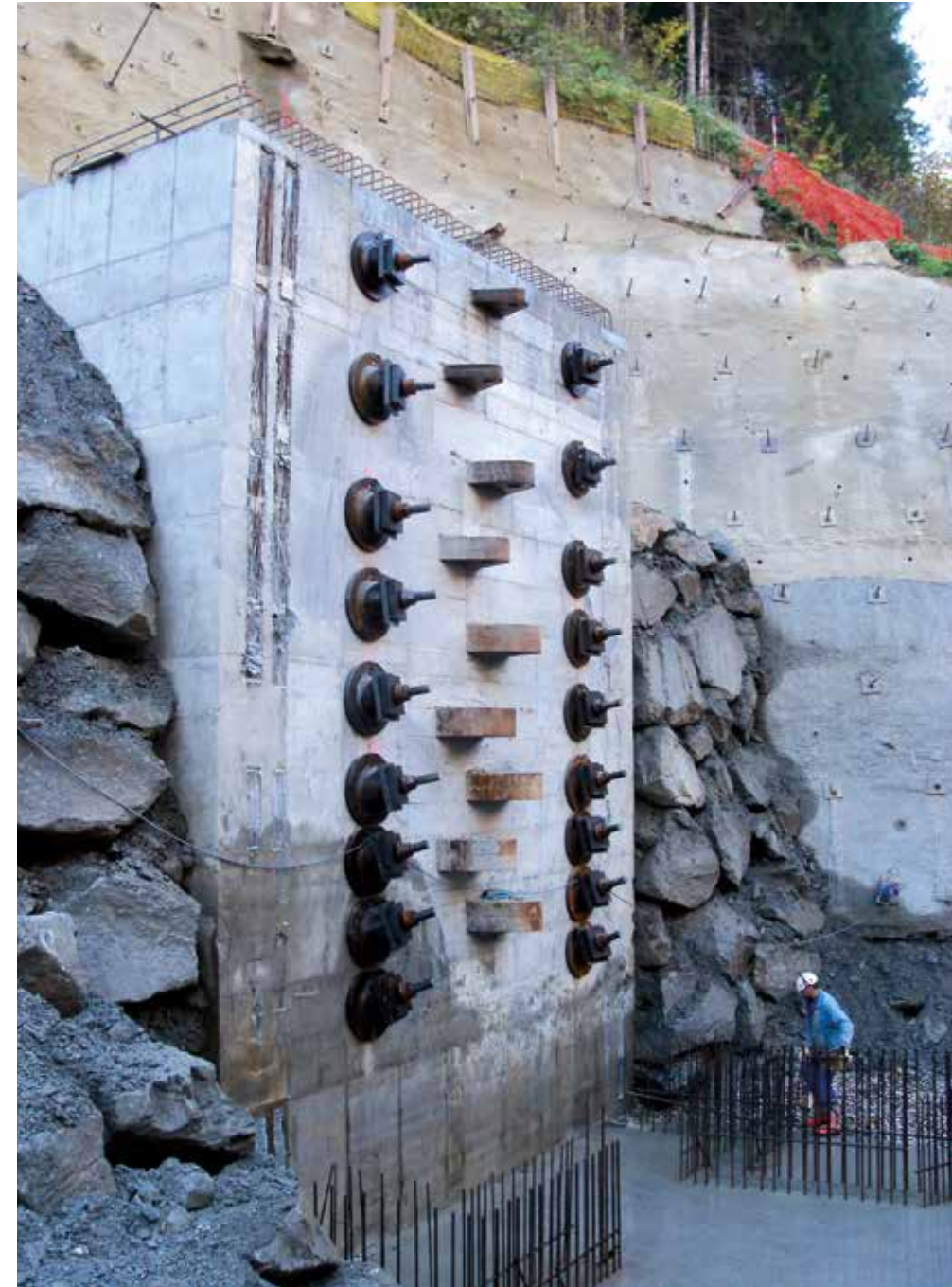
Abb. 12: Betonankerblock mit Stahlköpfen der Anker
