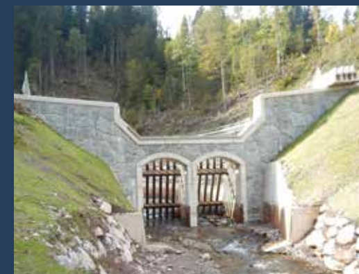
Abb. 3: Ansicht Filterbauwerk Schwarzleograbens
