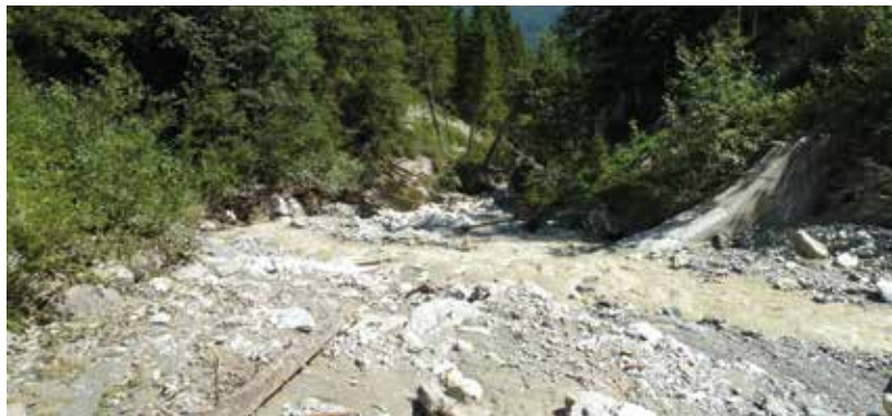
Abb. 10: Wildholzeintrag in gesicherten Gerinneabschnitten.
