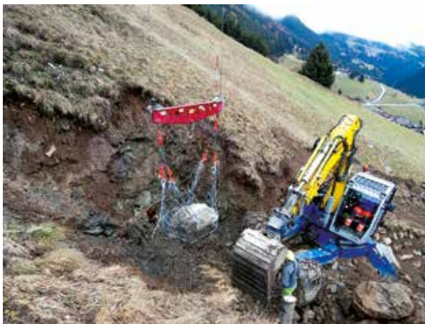
Abb. 3: Steintransport mittels Seilbahn
