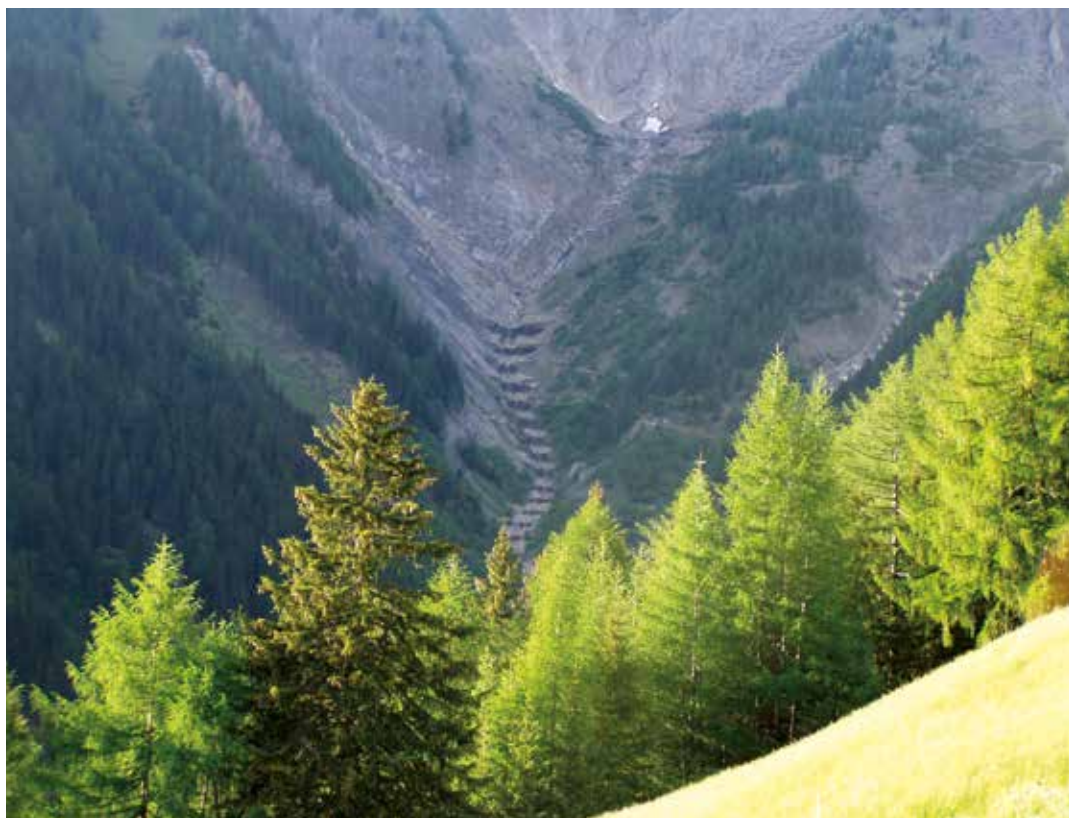
Abb. 4: Klassische Wildbachverbauung mittels Sperrenstaffelung im Bretterwandbach, Gde. Matrei, Osttirol
