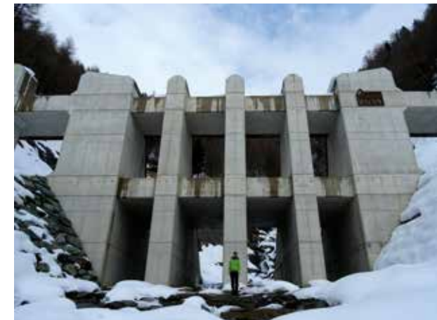
Abb. 2: Mur- und Lawinenbrecher Timmelbach-Lawine wasserseitig
