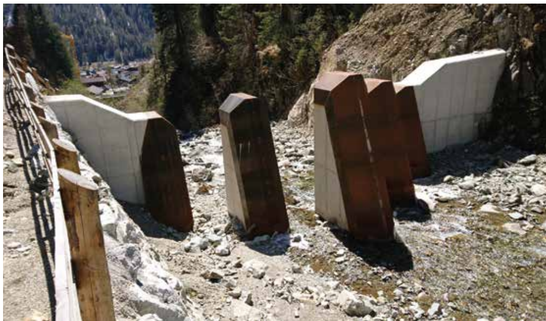
Abb.17: Murbrecher, Trojeralmbach, Gde. St. Jakob, Defreggental (2016/2017)
