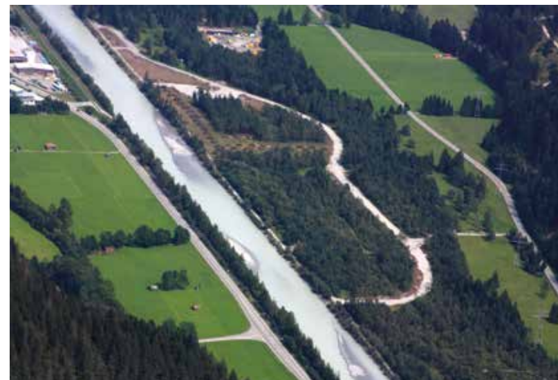
Abb. 9: Rodungsarbeiten Umgehungsgerinne, September 2012 (Foto: BBA Reutte)
