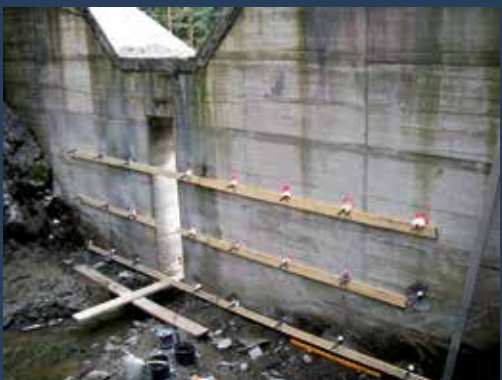
Abb. 1: fertig vergossene Stabankerstäbe wasserseitig, dreistufiger Ankerabstand 1,0 m
