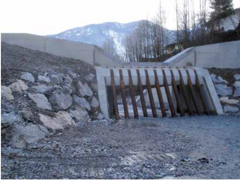
Abb. 2: Geschiebesperre mit Wildholzrechen.
