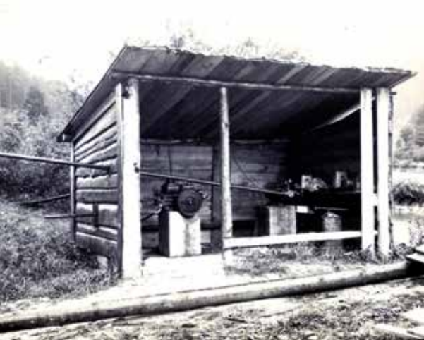
Abb. 5: Pumpanlage und waschen des Schotters für die Betonherstellung
