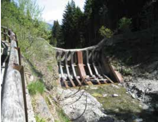
Abb. 6: Konstruktionsdetail der wasserseitigen Abdeckung mit einem geneigten Rechen vor dem Ereignis (Bild links) und nach einem Ereignis (Bild rechts). Wichtig ist der untere Tiroler Wehr ähnliche Teil im Bereich der Sohle.
