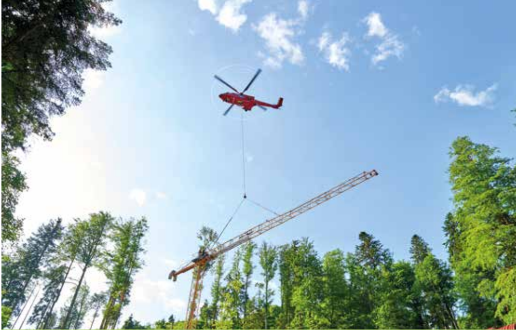
Abb. 5: Hubschraubermontage Kran
