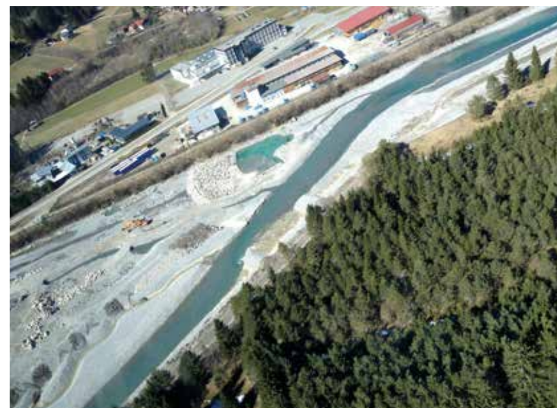
Abb. 10: Mündungsbereich Umgehungsgerinne und untere Sohlrampe km 182,78, April 2014 (Foto: BBA Reutte)
