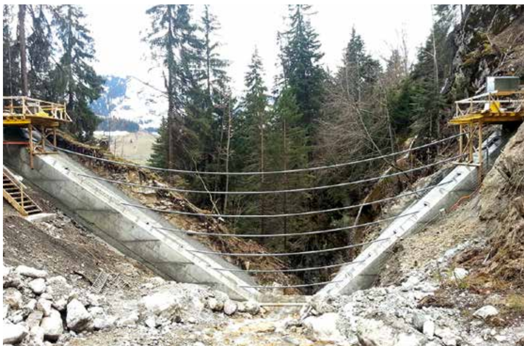
Abb. 9: Fertigstellung der Tragseile
