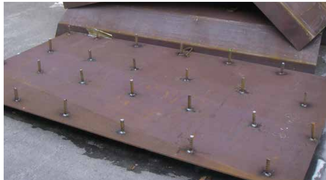
Abb. 6: Vorbereitete seitliche Flächenverkleidung mit Verbundzapfen 20 mm Torstahl – Raster 40/40 cm (Foto WLV)
