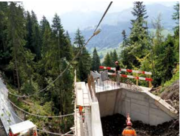
Abb. 8: Montage des oberen Hochleistungsseils mittels Kran. Die Stahlseile werden dann in die Stahleinlageteile eingelegt und fixiert.
