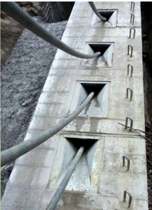
Abb. 8: Montage des oberen Hochleistungsseils mittels Kran. Die Stahlseile werden dann in die Stahleinlageteile eingelegt und fixiert.
