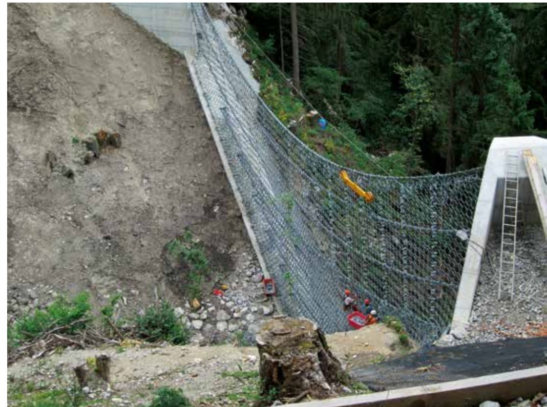
Abb. 10: Montage der Netzpaneelen
