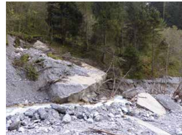
Abb. 9: Verdrehter und nach außen gekippter linksufriger Flügel der Sperre hm 18,62
