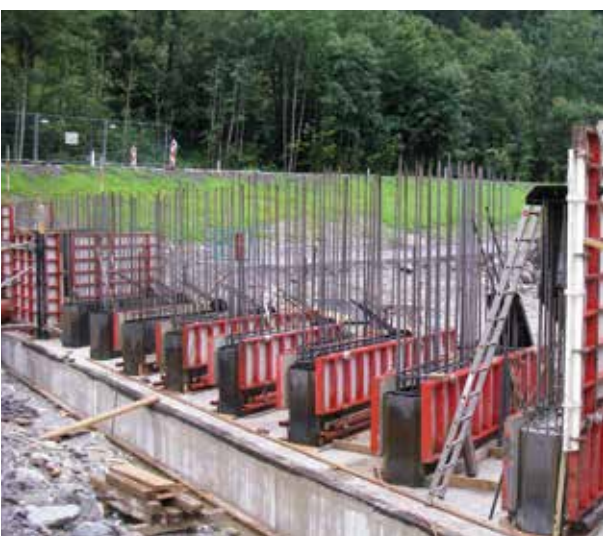
Abb. 5: Betonierfertige Einbausituation der vorgefertigten Stahlblechscheiben (Enns/Gemeinde Flachau, Foto WLV)
