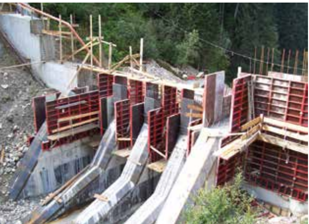
Abb. 17: Murbrecher mit aufgelösten Scheiben und flachem Anlaufteil (Scheiben mit Stahlblech gepanzert) – Murbrechende Wirkung und Ausfiltration von Wildholz im Zuge eines Ereignisses (Beispiel Aubach 2017, Bild rechts).
