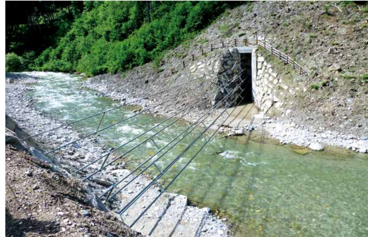
Abb. 15: Fertiggestellte Seilsperre
