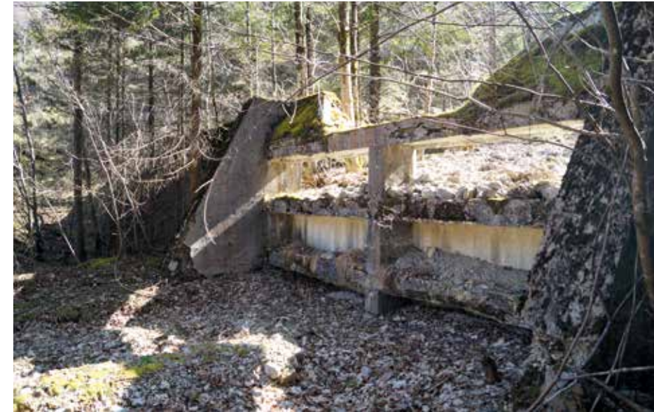
Abb. 12: Plattenbalkeneisenbetonsperre bei hm 1,83 im Jahr 2018
