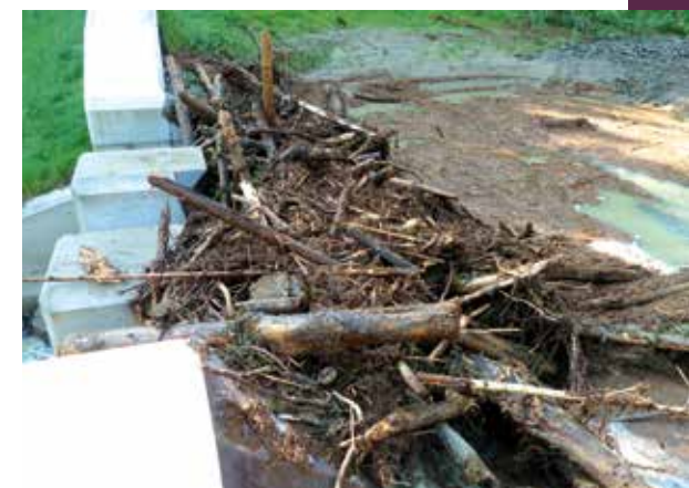
Abb. 13: Eine flach geneigte Filterkonstruktion bewirkt ein aufschwimmen des Wildholzes sodass Teile des Geschiebes durch das Bauwerk durchtransportiert werden
