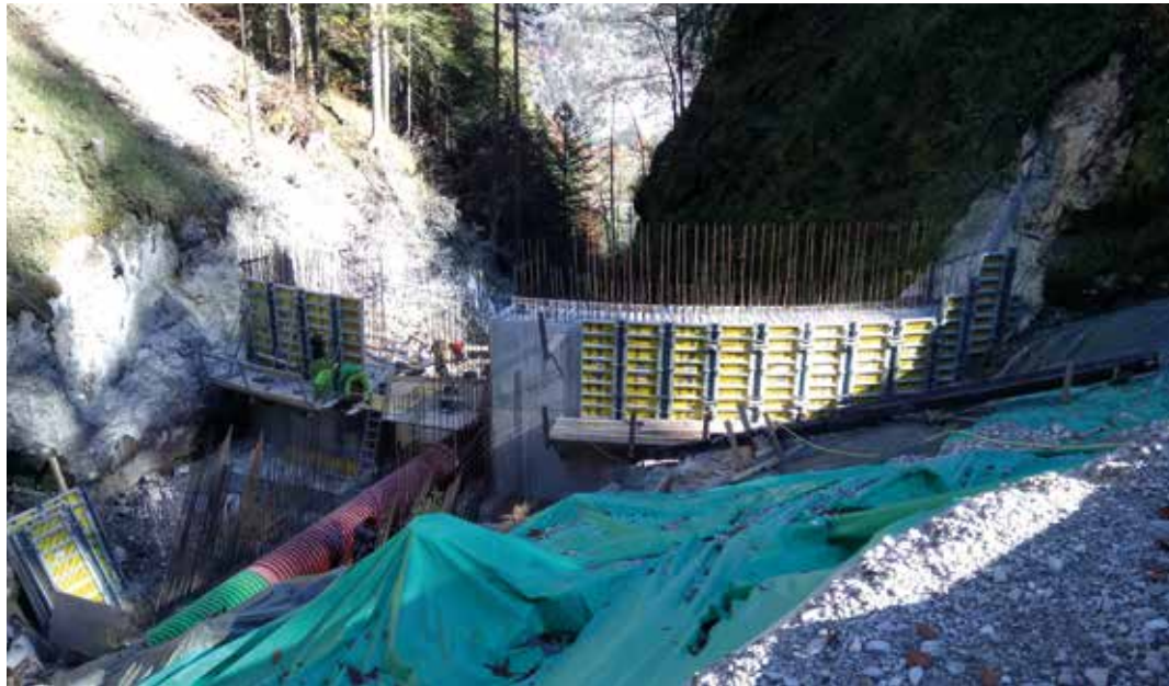
Abb. 8: Sperre – Schalungssystem
