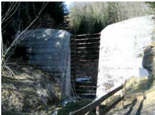
Abb. 4: Balkensperren – Geschieberückhalt hinter den Balken
