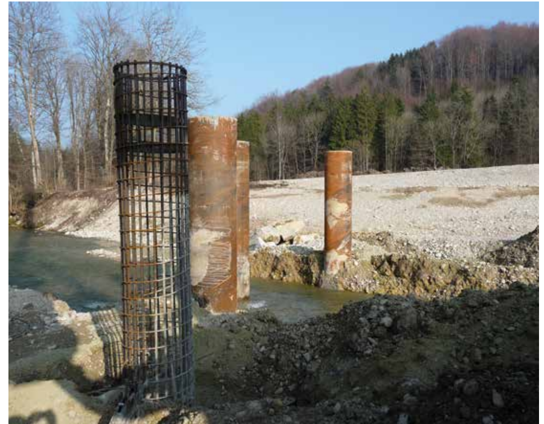
Abb. 3: Bewehrung für Stahlrohr (Foto: WWA Rosenheim).
