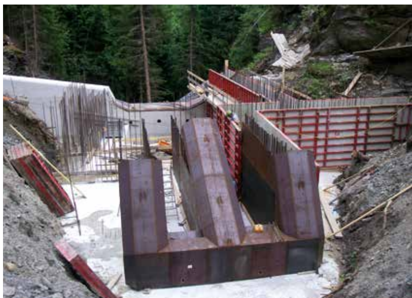
Abb. 11: Einbausituation eines Einlaufbereiches inkl. Trägerauflager mit anschließender Scheibenverblechung bei einer Sortiersperre (Fuchsbach/Gemeinde Tamsweg, Foto WLV)
