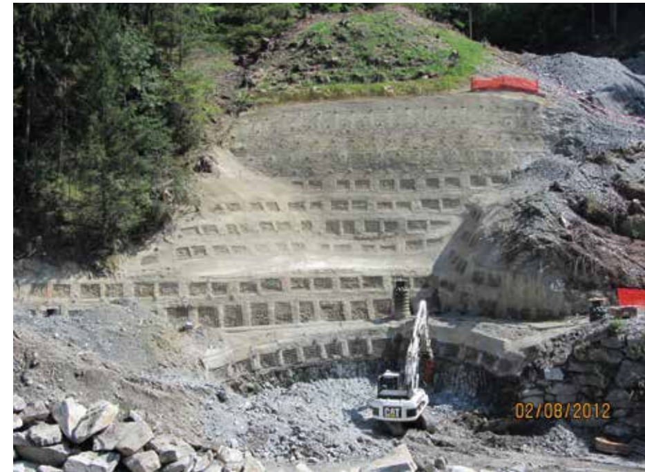
Abb. 8: Die Baugrubensicherung der Seilsperre auf der orografisch rechten Seite
