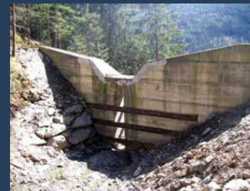
Abb. 5: wasserseitige Ansicht der fertig adaptierten Dosiersperre
