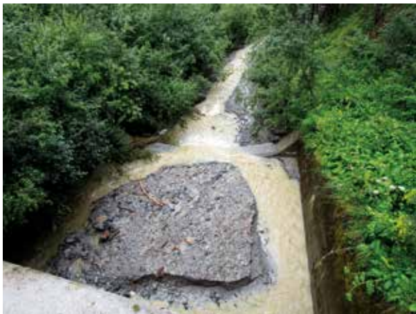
Abb. 14: Wildholzablagerung am Filterteil. Teile der Filterkonstruktion blieben frei, sodass ein Teil des Geschiebes im Zuge der ablaufenden Welle abtransportiert wurde.
