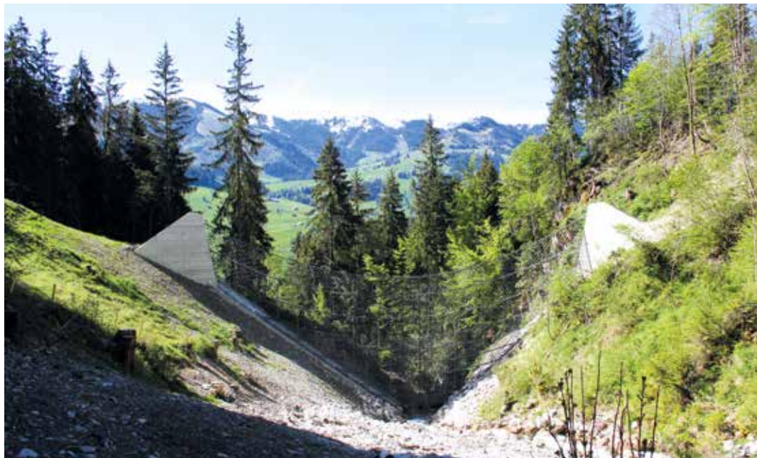
Abb. 11: Fertige Hüpach Murgangsperrre
