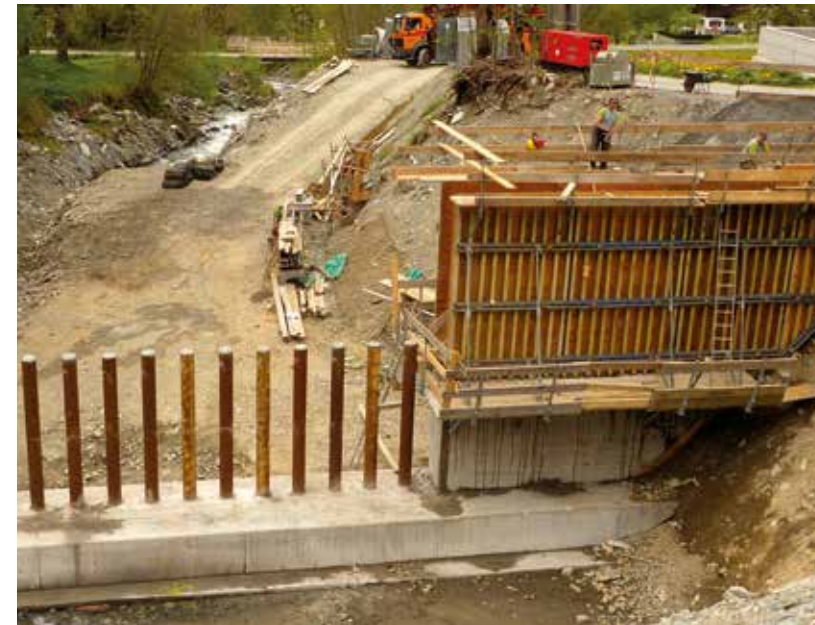
Abb. 4: Wildholzrechen während der Bauphase
