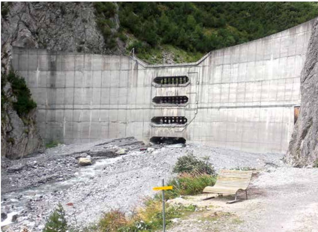
Abb.7: Schnannerbachsperre mit liegenden Großdohlen und Stahlrechen, Gemeinde Pettneu am Arlberg
