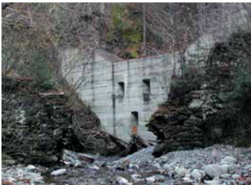
Abb. 2: Großdilige Entleerungssperren - Wildholz verlegt die Öffnungen, danach erfolgt eine sofortige Verfüllung des geschaffenen Ablagerungsraumes
