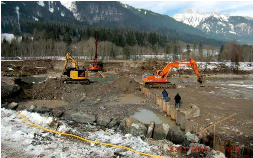
Abb. 12: Bau Sohlrampe km 183,40, Jänner 2015 (Foto: BBA Reutte)
