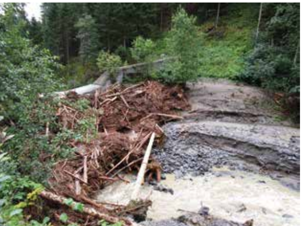
Abb. 14: Wildholzablagerung am Filterteil. Teile der Filterkonstruktion blieben frei, sodass ein Teil des Geschiebes im Zuge der ablaufenden Welle abtransportiert wurde.
