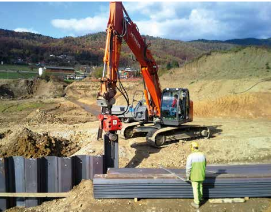
Abb. 3: Einrammen der Spundwände mit Spundwandramme (Typ MS-6 HFB)
