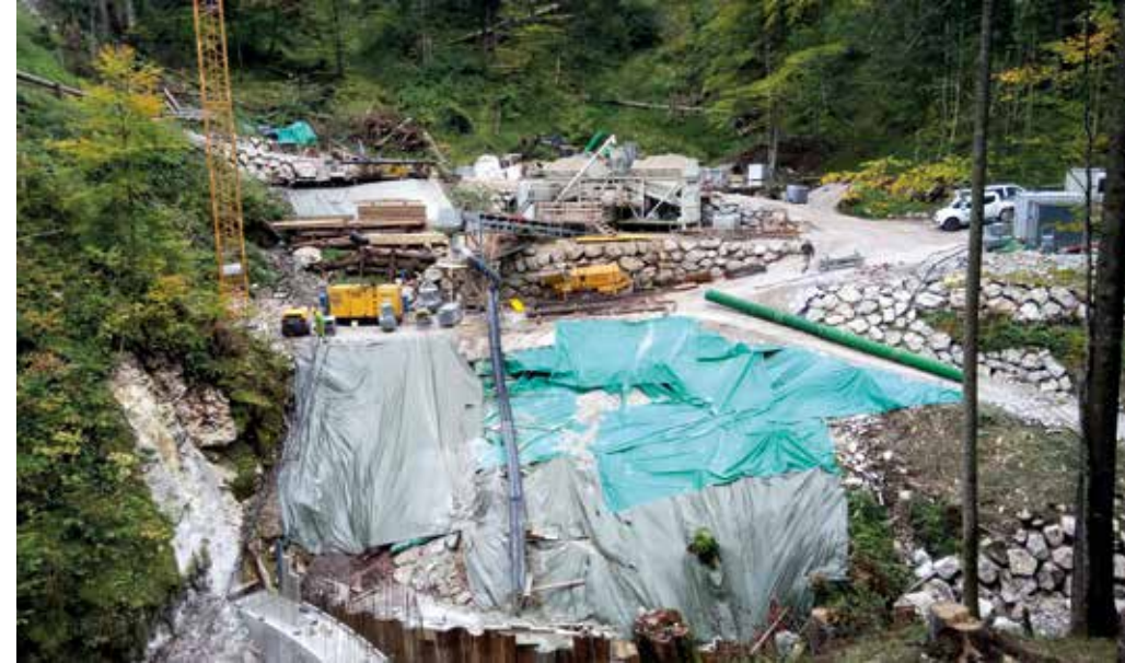
Abb. 6: Baustelleneinrichtung – Kran, Mischanlage mit Förderband, Baustraße
