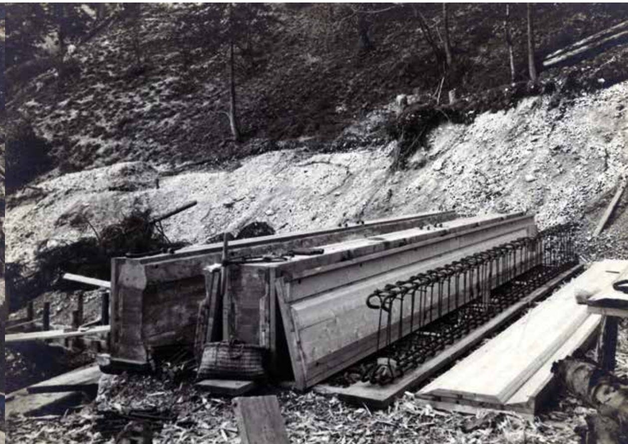
Abb. 9: Eisenbetonbalken Patent Lenz-Braun an der Fertigungsstelle
