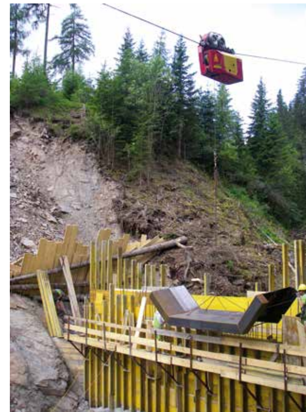
Abb. 9: Einbau einer Stahlabflusssektion mittels Seilbahn (Woodliner) (Lampeigraben/Gemeinde Tamsweg, Foto WLV)
