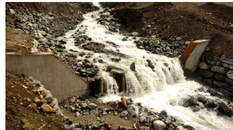
Abb. 7: „Kamm Sperre“ bei Mittelwasser
