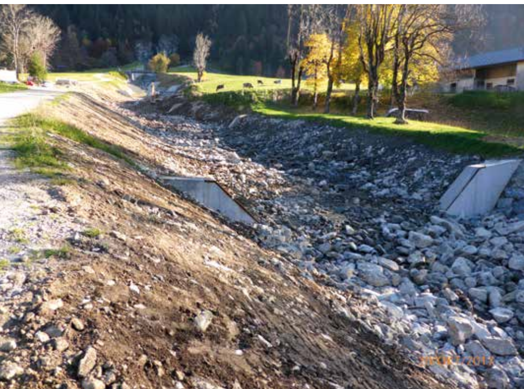
Abb. 9: nach Hinter- füllung
