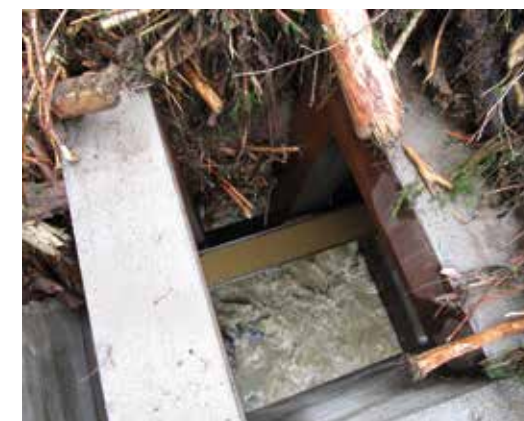
Abb. 16: Der horizontale Teil der Rechenkonstruktion in Ausführung eines Tiroler Wehres führt zur Entwässerung und somit zur Ablagerung der Wildholzmenge (Bild links); Der horizontale Teil hat eine Mindestlänge aufzuweisen, sonst könnte eine Abtrift einer Teilmenge des angeschwemmten Wildholzes erfolgen (Bild rechts).
