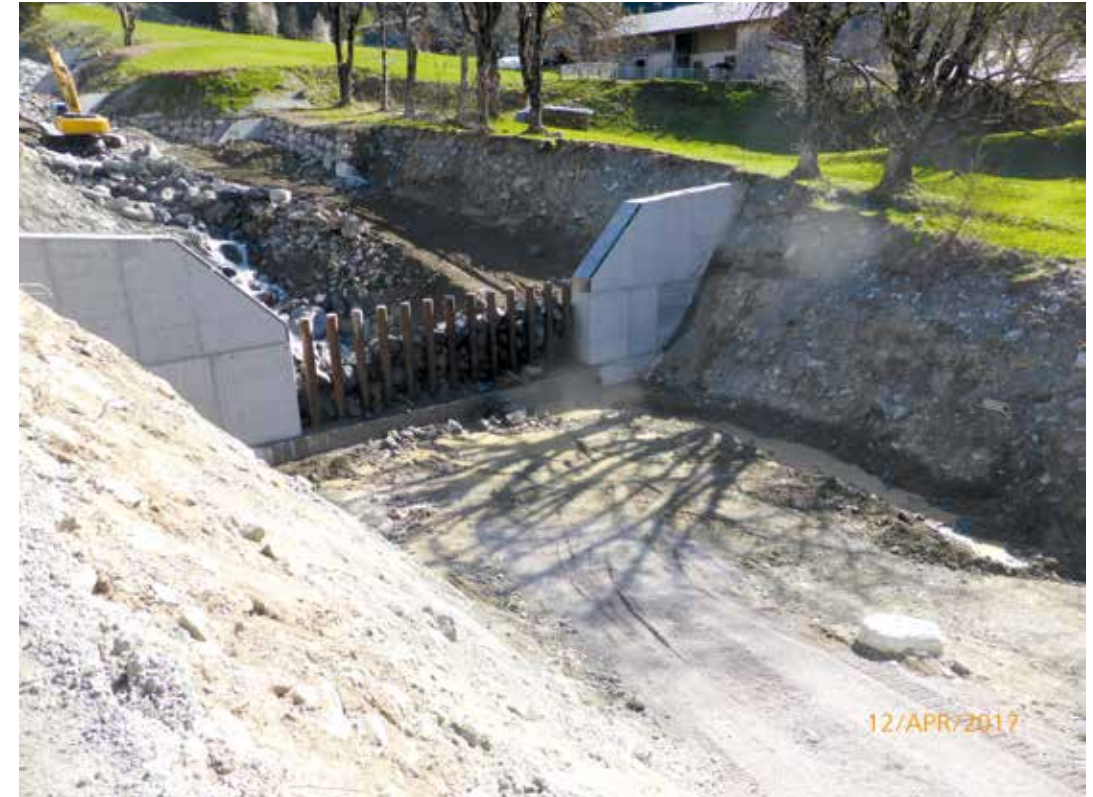
Abb. 6: „Kamm Sperre“ vor Hinterfüllung
