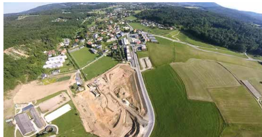
Abb. 2: Luftbild vom HWRHB Andritzbach während der Aushubphase
