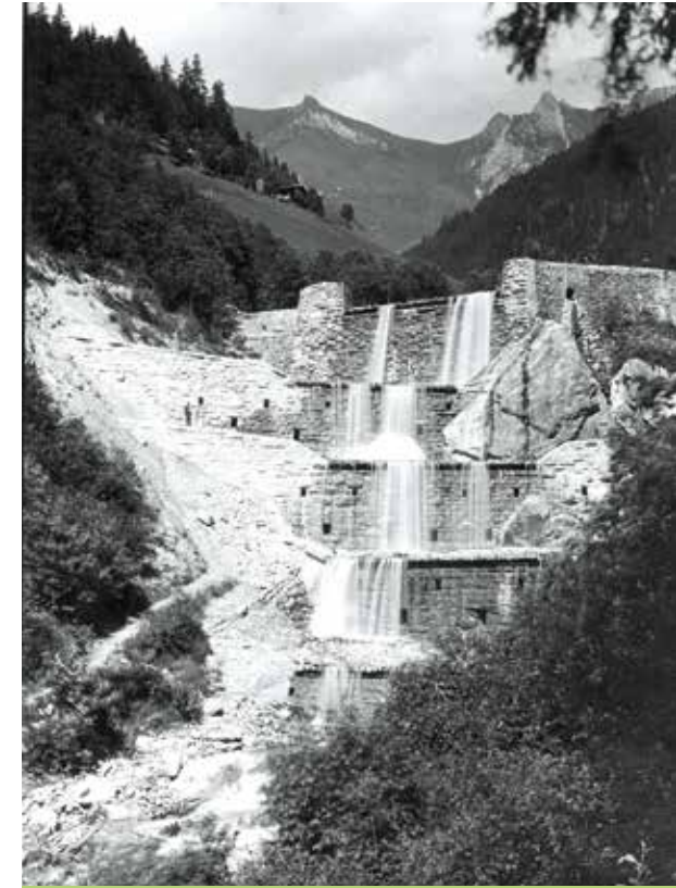
Abb. 1: Historische Querbauwerke in der Schluchtstrecke des Bretterwandbaches; Gemeinde Matrei i. O.
