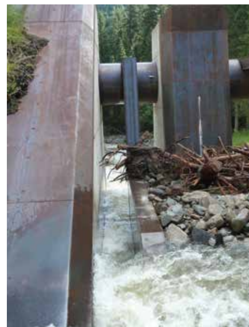
Abb. 13: Eine flach geneigte Filterkonstruktion bewirkt ein aufschwimmen des Wildholzes sodass Teile des Geschiebes durch das Bauwerk durchtransportiert werden
