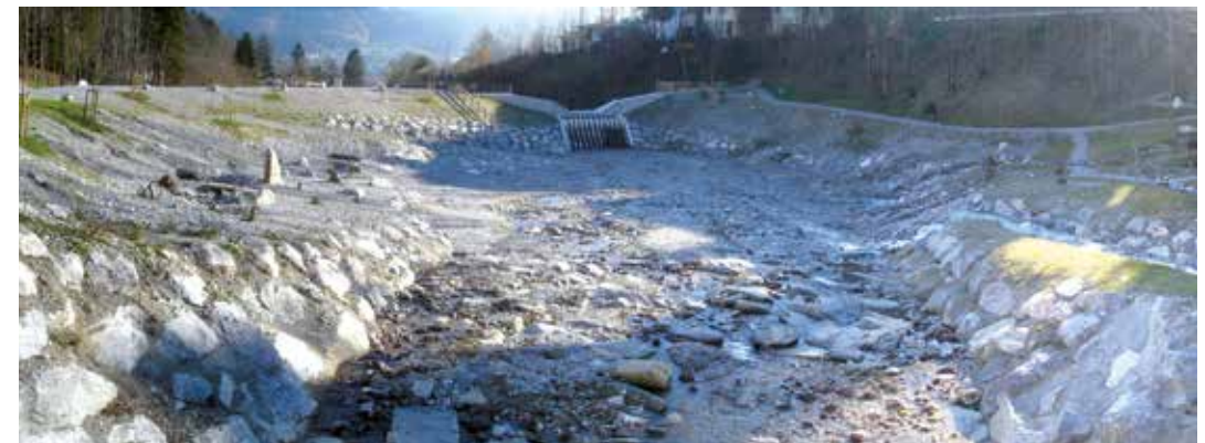
Abb. 1: fertiges Geschieberückhaltebecken mit Wildholzrechen.
