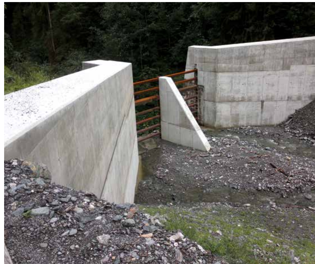
Abb. 18: Sanierung der Verbauung Riedbach, Gde. Ried im Zillertal
