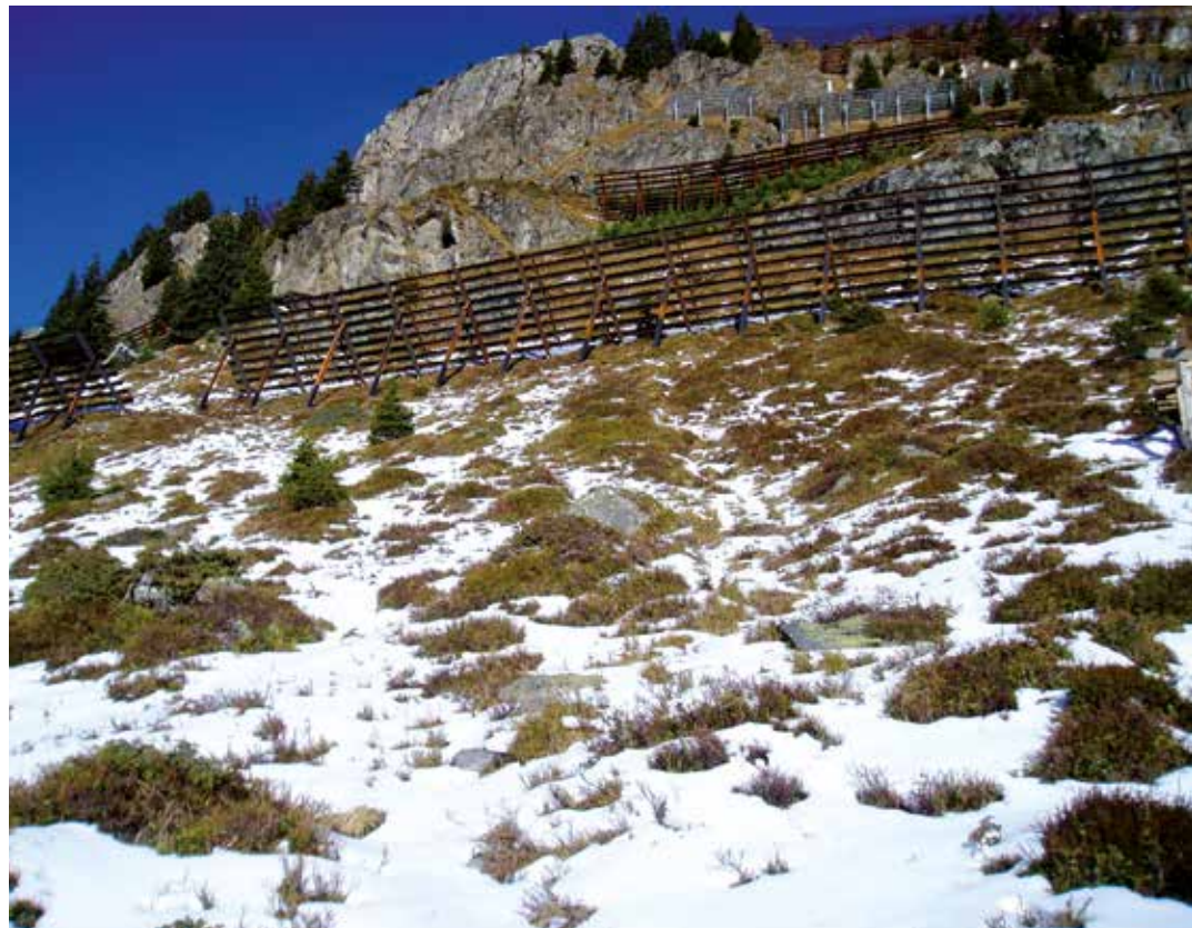
Abb. 10: Festlegung von Kleinstandorten. Auf Grund dieser Schneeverteilung, natürlichen Verjüngungskegeln, Bodenvegetation und großen Steinen, ergeben sich mögliche Aufforstungsstandorte quasi automatisch. Tafamuntlawine/Partenen
