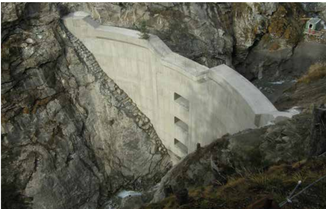
Abb. 13: Geschiebesortiersperre Stubenbach, Gde Pfunds; horizontal liegende Großdohlen mit dahinter liegendem Rechenkorb
