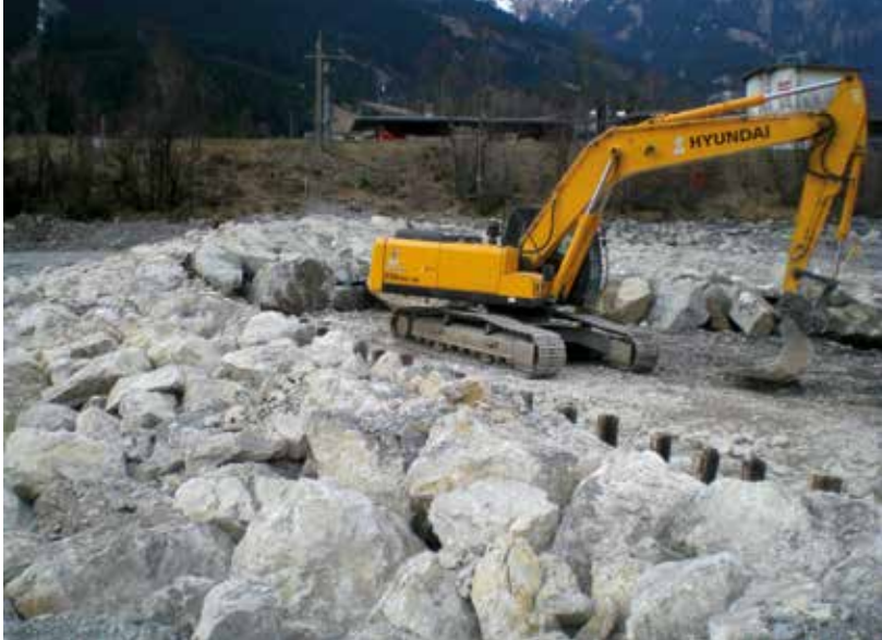
Abb. 11: Bau Sohlrampe km 182,78, März 2014 (Foto: BBA Reutte)
