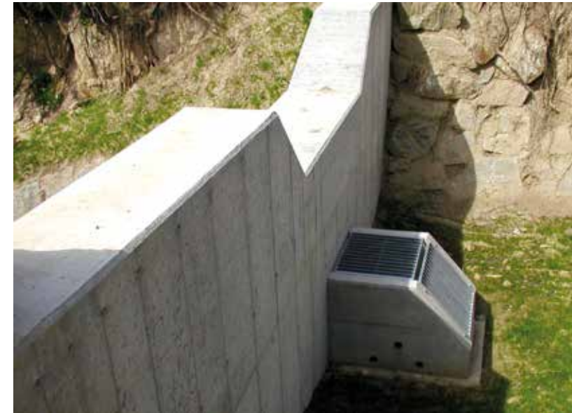
Abb.3: Blick wasserseitig auf eine fertig eingebundene Wasserrückhaltesperre am Rosenberggraben (Gde. Grafenwörth)
