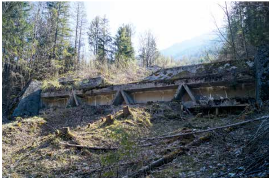
Abb. 11: Plattenbalkeneisenbetonsperre bei hm 0,53 im Jahr 2018
