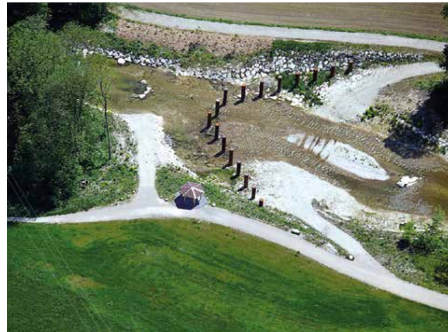
Abb. 5: Luftbildaufnahme des fertiggestellten Schwemmholzrechens mit Zufahrten zum Rückhalteraum (Foto: WWA Rosenheim).
