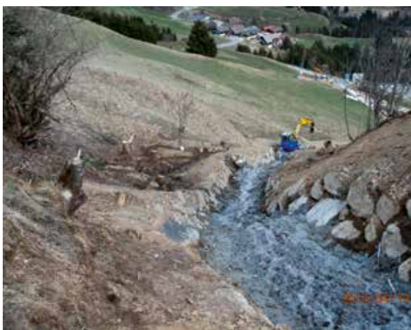
Abb. 4: Mit Wasserbausteinen gesichertes Steilgerinne; Verbauung Gsaritzerbach, St. Veit i. Def.
