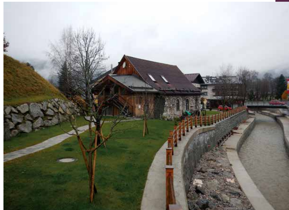
Abb. 2: Fertiggestellter und rekultivierter Gerinneabschnitt, Urslau, Gemeinde Saalfelden
