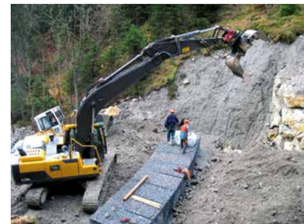
Abb. 1: Errichtung einer Gabionensperre
