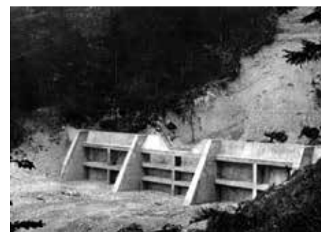
Abb. 10: Plattenbalkeneisenbetonsperre bei hm 1,83 nach Fertigstellung
