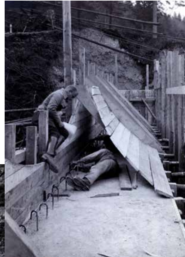
Abb. 6: Schalungsarbeiten und fertiges Bauwerk (Sperre II)
