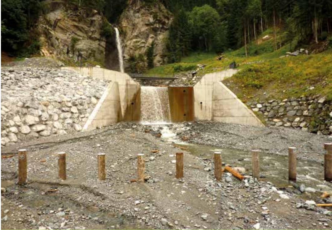
Abb. 5: Absturzwerk und Wildholzrechen
