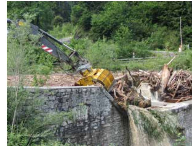
Abb. 19: Wasserseitiger Zufahrtsweg zur Räumung des funktionellen Teils mit schwerem Gerät
