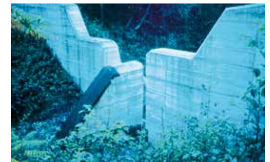
Abb. 1: Beispiele von Schlitzsperrn ohne (links) und mit (rechts) Murbrecher (Armanini & Larcher, 2001).
