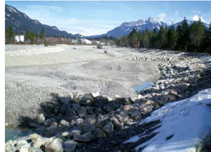
Abb. 13: Aushub Umgehungsgerinne, März 2013 (Foto: BBA Reutte)
