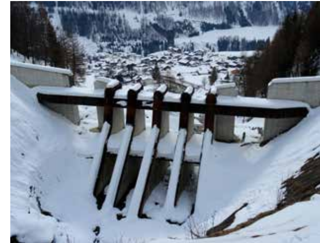
Abb. 1: Mur- und Lawinenbrecher Timmelbach-Lawine luftseitig
