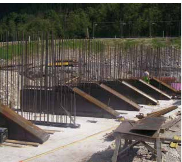
Abb. 4: Fertig versetzte Wildholzfilterscheiben (Enns/Gemeinde Flachau, Foto WLV)
