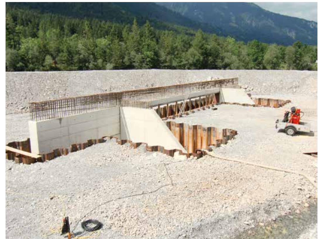
Abb. 14: Bau Drosselbauwerk, August 2014 (Foto: BBA Reutte)
