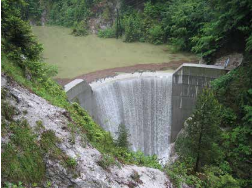
Abb. 19: Hochwasserretention Wörglerbach, Gde Wörgl
