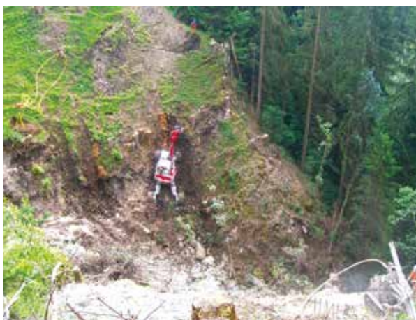
Abb. 5: Erstellung von seitlichem Aushub für das Widerlager mit einem Schreitbagger.
