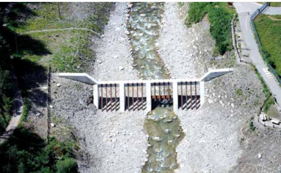
Abb. 5: Fertiggestelltes oberes Bauwerk
