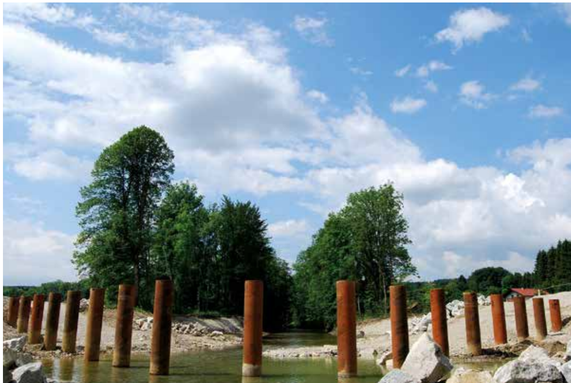
Abb. 4: Stahlrohre nach Fertigstellung (Blick von unterstrom) (Foto: WWA Rosenheim).
