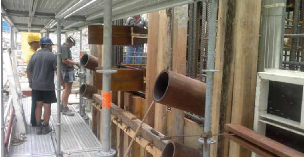
Abb. 10: Richtungsgebung der Ankerbohrungen mittels Stahlrohren
