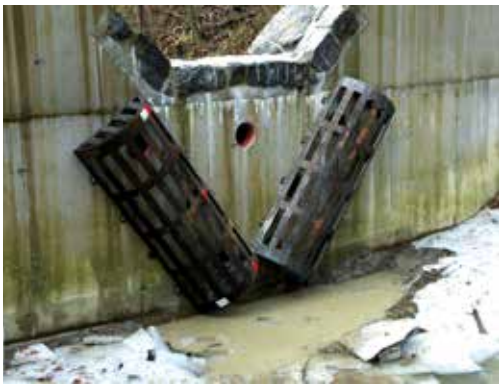
Abb. 1: Ansicht der Sperre; die Dolen wurden mit einem mit Längsschnitzen versehenen Halbrohr geschützt.
