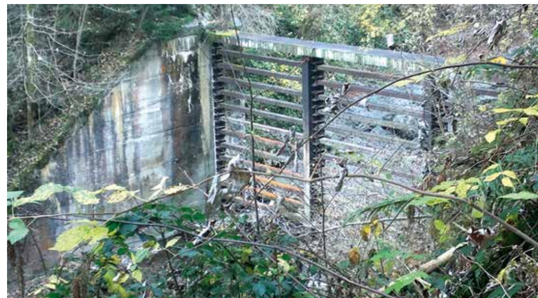
Abb. 6: Trogförmige Betonsperre mit horizontalen Stahlbalken im Wattenbach, Markgemeinde Wattens
