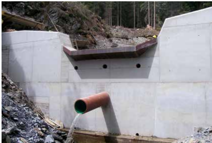
Abb. 10: Fertig eingebaute Stahlabflusssektion inkl. Konsolenverblechung bei einer Vorsperre (Fuchsbach/ Gemeinde Tamsweg, Foto WLV)
