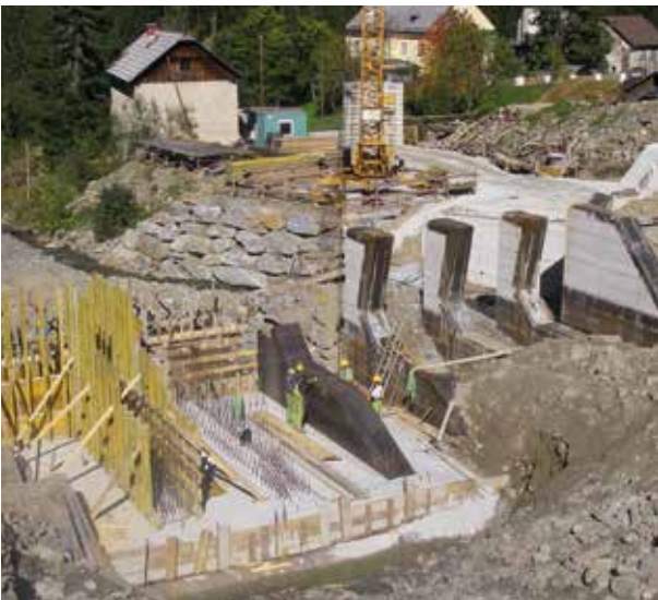
Abb. 3: Einbau der Mittelscheibe (rechtes Bild) (Beispiel Weißbach/Gemeinde Thomatal, Foto WLV)
