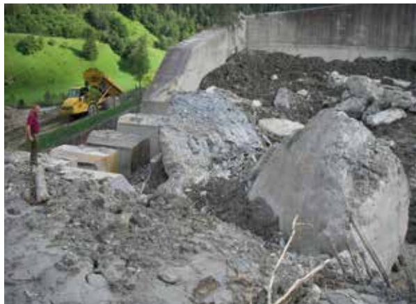
Abb. 17: Murbrecher mit aufgelösten Scheiben und flachem Anlaufteil (Scheiben mit Stahlblech gepanzert) – Murbrechende Wirkung und Ausfiltration von Wildholz im Zuge eines Ereignisses (Beispiel Aubach 2017, Bild rechts).
