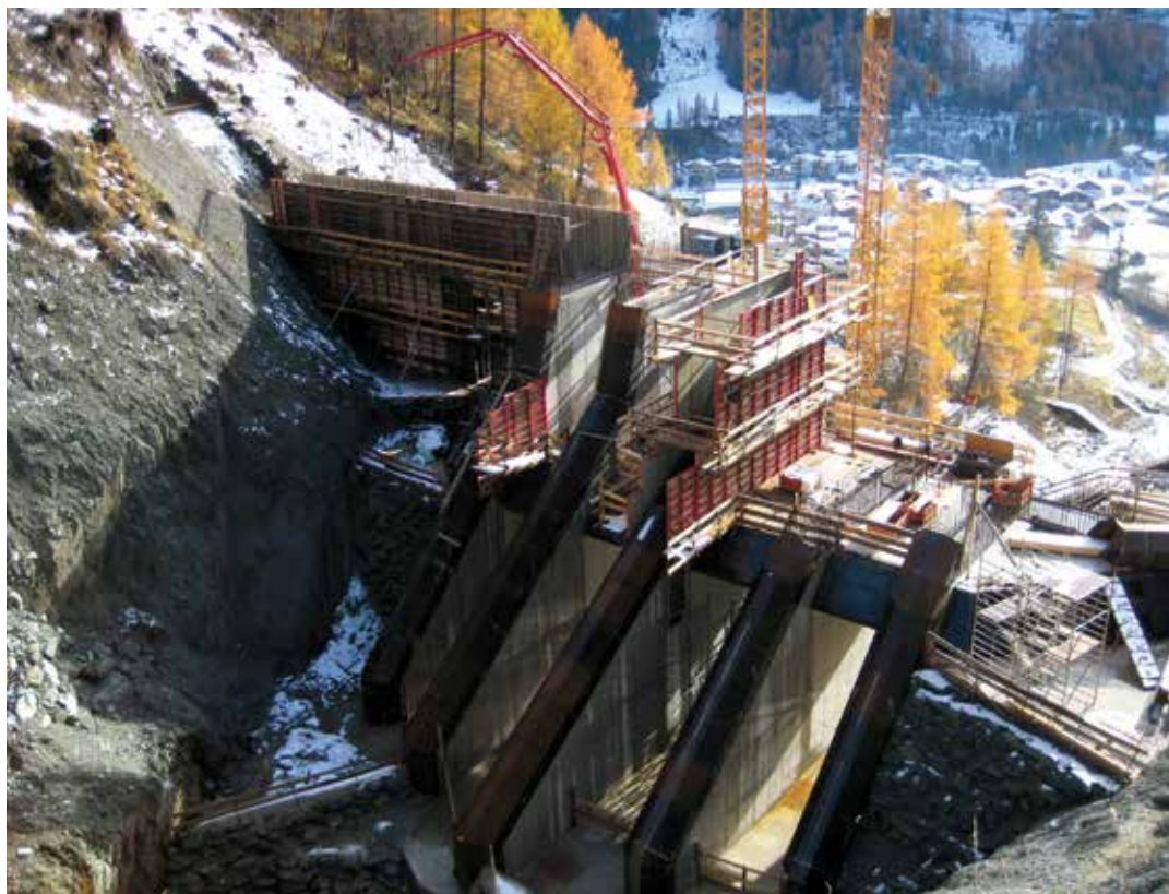
Abb. 7: Betonieren des orographisch linken Flügels
