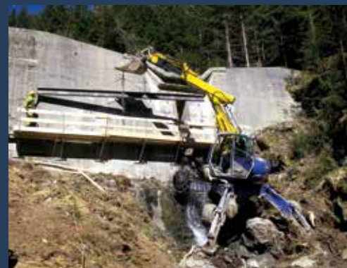
Abb. 3: Versetzen der UNP-300 Stahlträger mittels Schreitbagger
