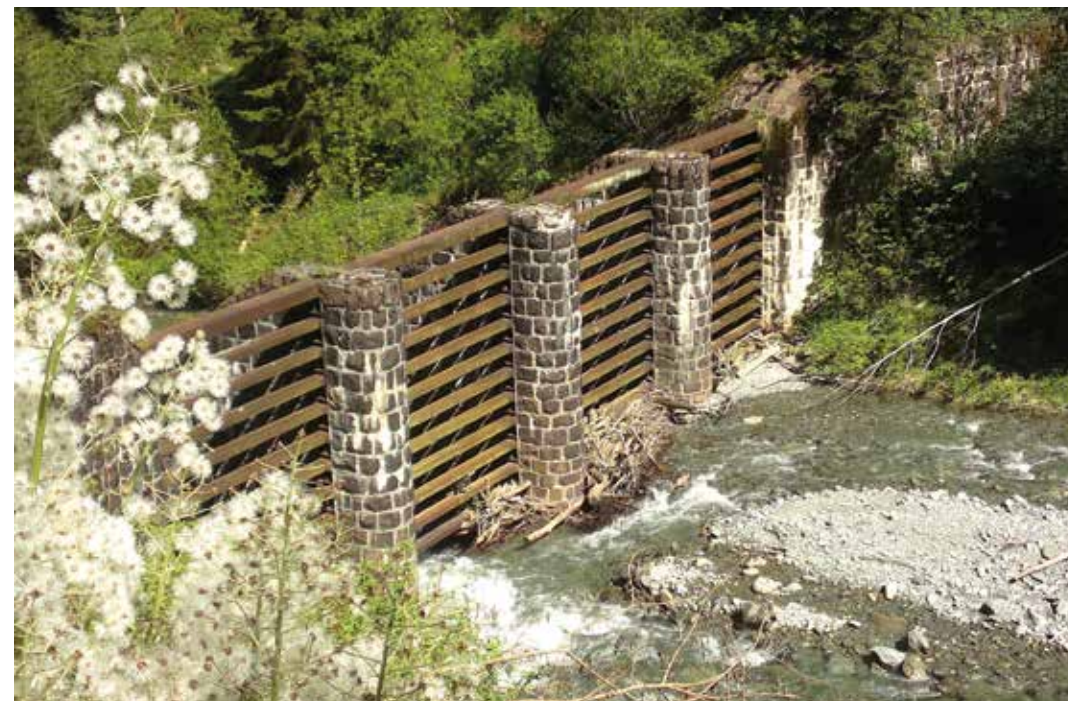
Abb. 5: Die vierfeldrige Balkensperre im Märzenbach in der Gemeinde Stumm, errichtet 1969
