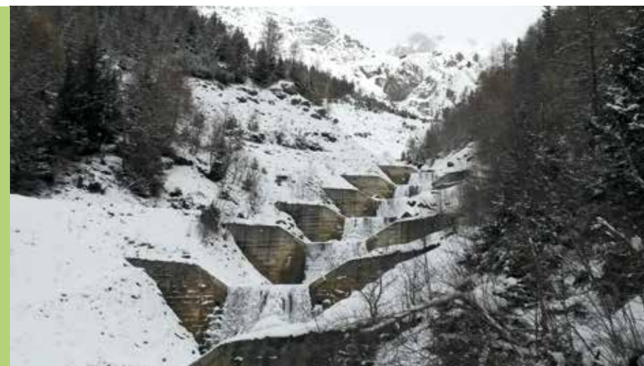
Abb. 5: Konsolidierungssperrenstaffelung in Stahlbeton; Bretterwand torrent, municipality Matrei i. O.
