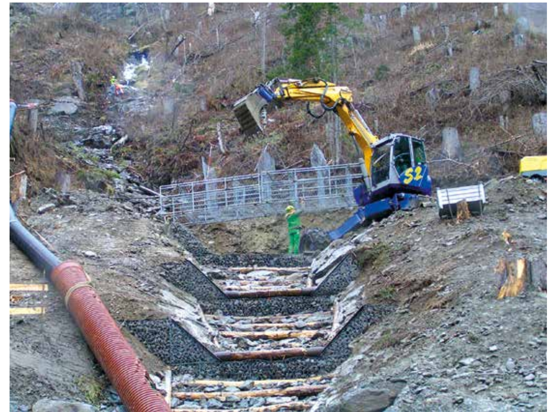
Abb. 7: Einheben der Maccaferri Drahtkörbe
