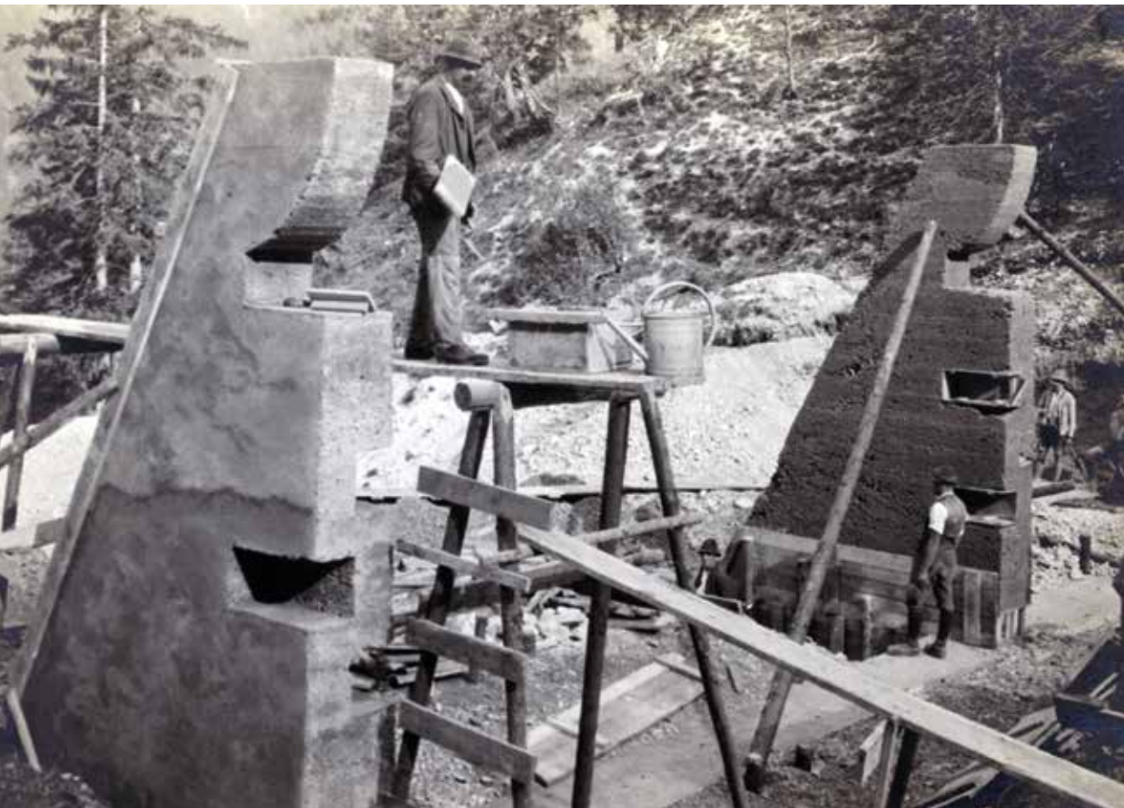
Abb. 8: Verputzarbeiten beim Widerlager der Sperre III
