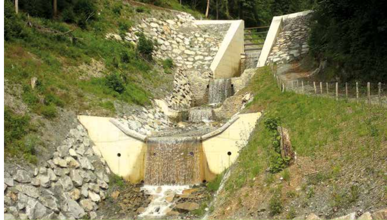
Abb.20: Sanierung der Verbauung Walsenbach, Gde. Kitzbühel
