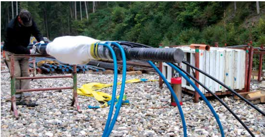
Abb. 11: Verpresspacker zum Nachverpressen der Anker
