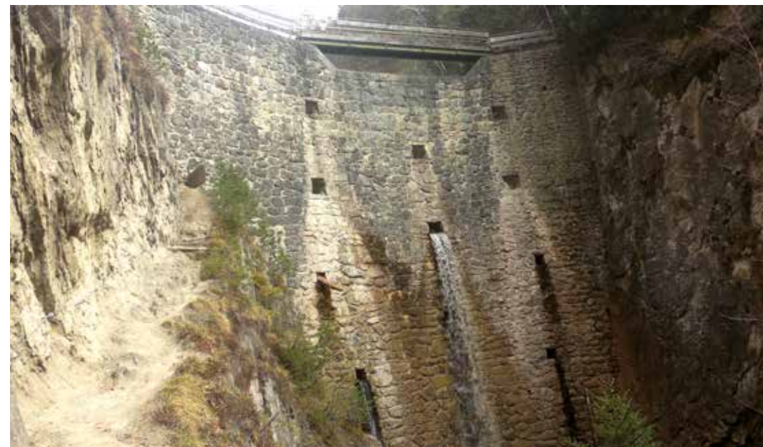
Abb. 3: Gspannsperre in der Gemeinde Zirl, in den Jahren 1954 bis 1962 von 6 auf 25 m erhöht
