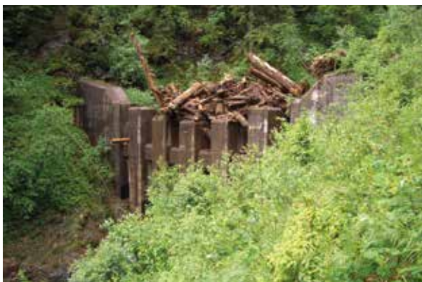
Abb. 15: Wasserrückstau infolge Murscheiben, Feingeschiebe wurde durchgeschleust und Ablagerung von Wildholz im Stauraum
