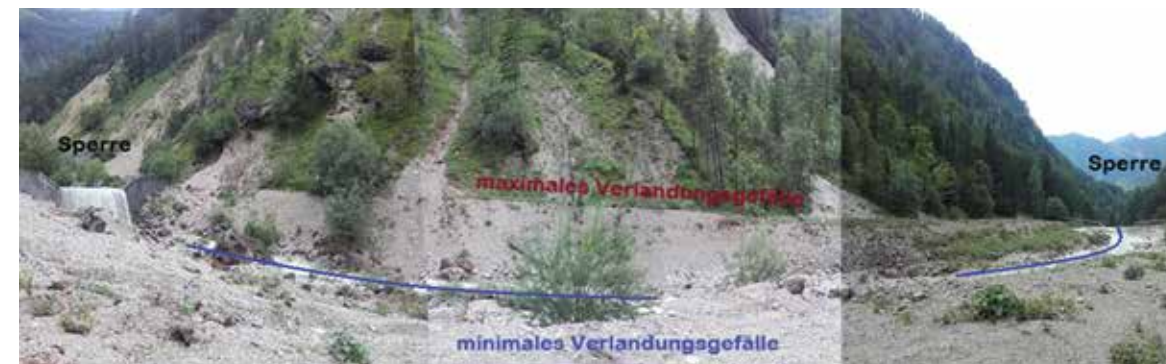
Abb. 1: Veränderung des Verlandungsgefälles innerhalb einer Staffelung, Gimbach, 2017 (Foto: Bramberger)
