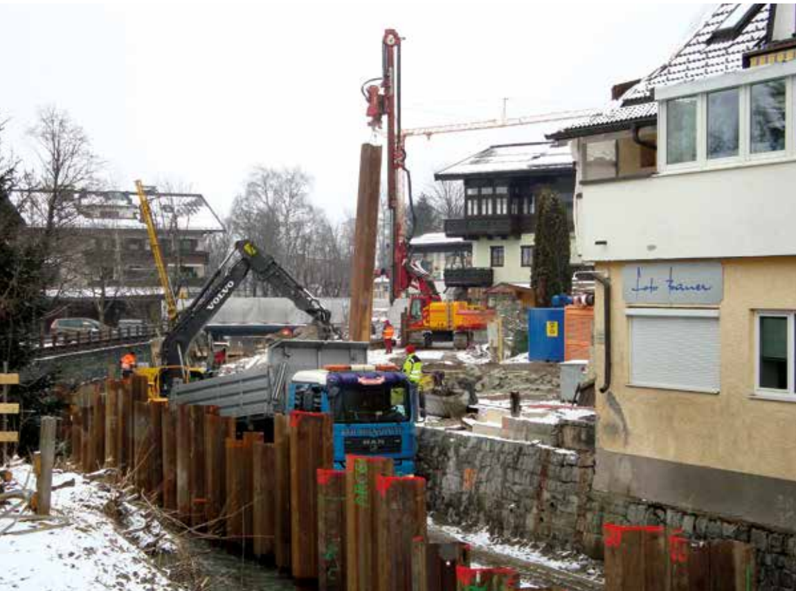
Abb. 1: Parallel laufende Arbeiten an der Baustelle Urslau 2013 (Spundwand, HDBV, Aushub); ein Gebäude steht direkt auf der orografisch rechten Ufermauer
