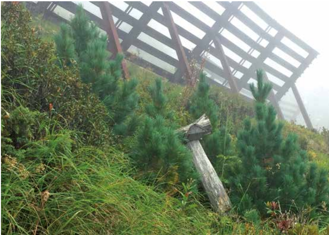
Abb. 8: Gleitschutzbock aus Robinienholz mit Wirkhöhe d=0,8\text{m} mit Zirbengruppe (Alter ca. 12 Jahre) zwischen Technischer Verbauung, Kälberhaldelawine/Gargellen
