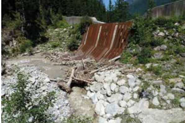
Abb. 6: Konstruktionsdetail der wasserseitigen Abdeckung mit einem geneigten Rechen vor dem Ereignis (Bild links) und nach einem Ereignis (Bild rechts). Wichtig ist der untere Tiroler Wehr ähnliche Teil im Bereich der Sohle.
