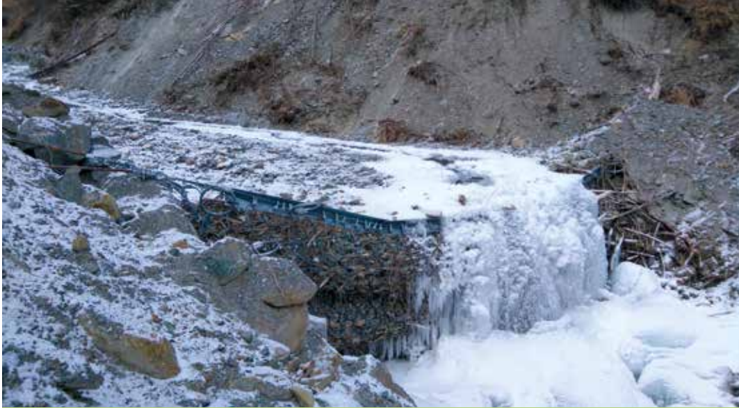
Abb. 8: Netzsperre als Konsolidierungsbauwerk im Erlbach; Gemeinde Abfaltersbach
