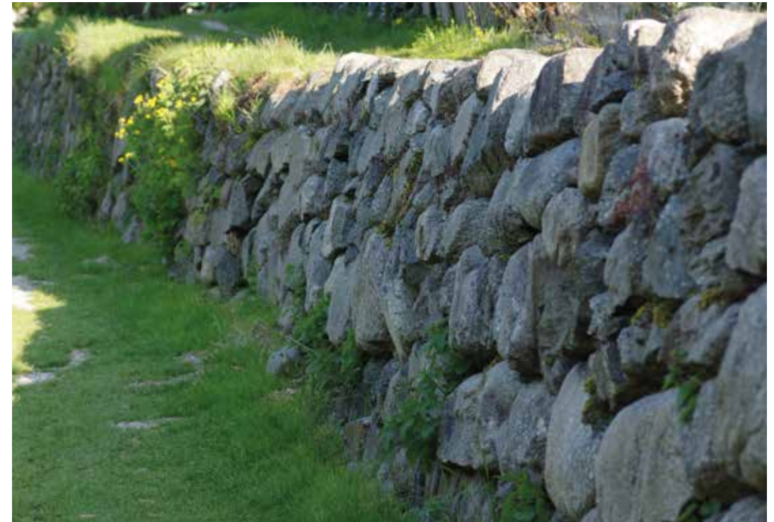
Abb. 1: Lahnbachmauer in Schwaz
