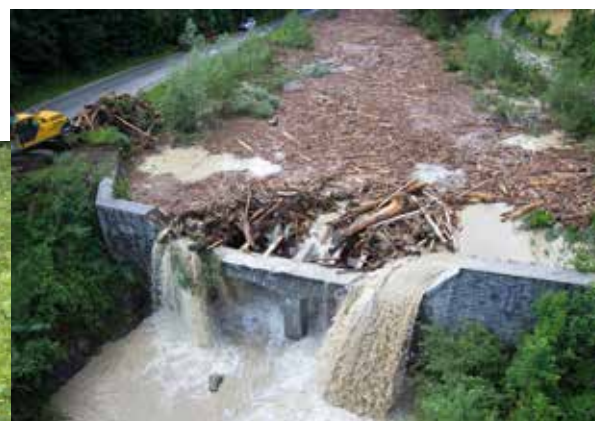
Abb. 16: Der horizontale Teil der Rechenkonstruktion in Ausführung eines Tiroler Wehres führt zur Entwässerung und somit zur Ablagerung der Wildholzmenge (Bild links); Der horizontale Teil hat eine Mindestlänge aufzuweisen, sonst könnte eine Abtrift einer Teilmenge des angeschwemmten Wildholzes erfolgen (Bild rechts).
