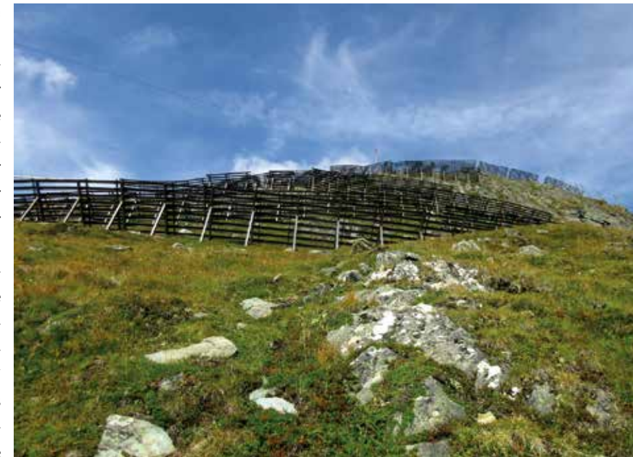
Abb. 2: Lawinenanbruchverbauung; Timmelbach Lawine, Prägraten a. Gr.
