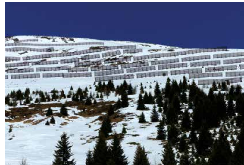
Abb. 1: Lawinenanbruchverbauung; Oberseit Lawine, St. Jakob i. Def.
