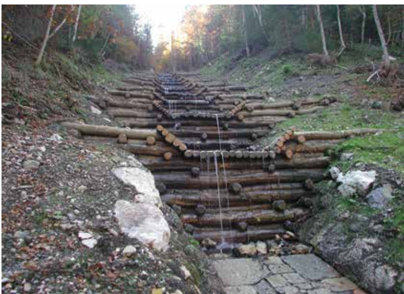
Abb. 4: Errichtete Holzquerbauwerke im Jagdhüttengraben aus dem Jahr 2003 (Quelle: WLV).
