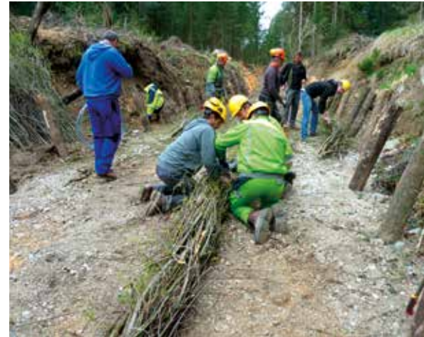
Abb. 2. Bau einer Faschine (links) und Weidenspreitlage (rechts), ingenieurbioologischer Baukurs, Tirol, 2014.
