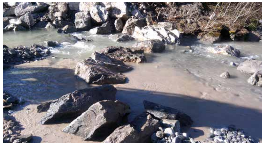
Abb. 5: Verlegung der Sohlgurte in einem Bogen mit mittlerer Abflusssequenz, die zum Ufer ansteigend ist und von Riegel zu Riegel etwas pendelt
