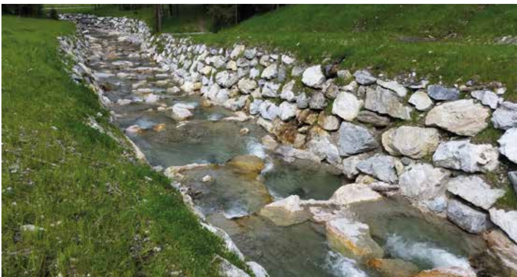
Abb. 1: Fischpassierbare Rampe am Zauchbach, Höhendifferenz 10 m
