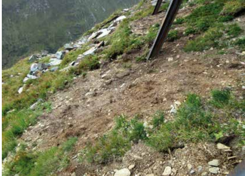
Abb. 3: Huderplätze im Schatten der Stahlschneebrücke; Timmelbach Lawine, Prägraten a. Gr.
