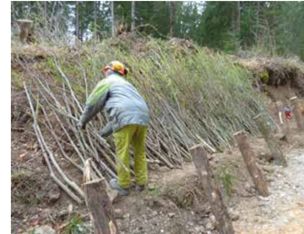
Abb. 2. Bau einer Faschine (links) und Weidenspreitlage (rechts), ingenieurbioologischer Baukurs, Tirol, 2014.
