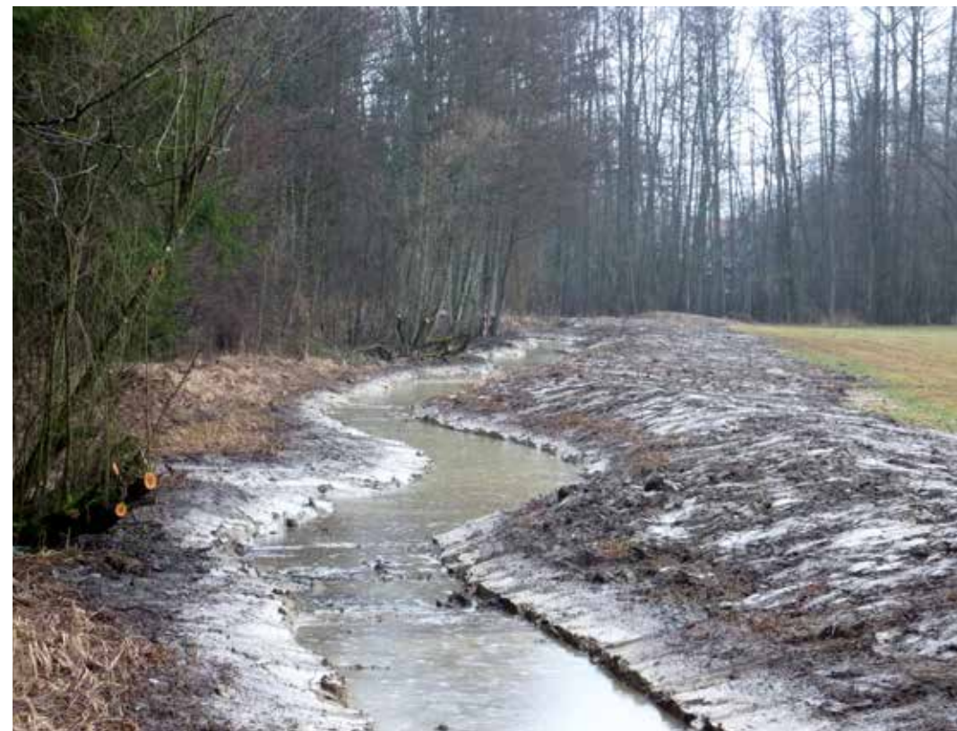
Abb. 3: Der neu angelegte Riedelbach-Unterlauf wurde der eigendynamischen Entwicklung überlassen.
