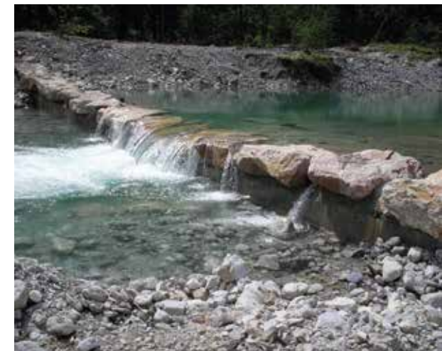
Abb. 2: Neubau von Betongrundschnellen mit strukturierter Krone aus Wasserbausteinen mit verschiedenen Abflusshöhen. Die Steine sind mit Lücken verlegt um ein Durchwandern von Kleinstlebewesen zu ermöglichen.
