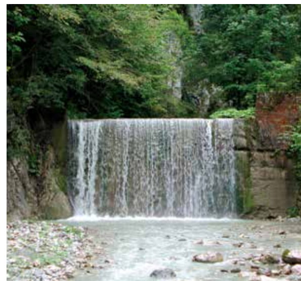
Abb. 7: Vorderbergerbach, Gemeinde. St. Stefan im Gailtal: Fischpassierbarer Bachausbau durch Entfernung von 4 Sperren (© Hufnagl, WLV)
