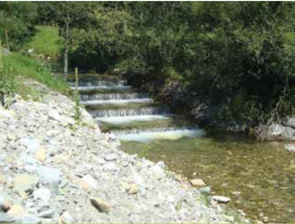
Abb. 9: Einlaufbauwerk des Beckens vor und nach dem Umbau (Steinrampe wurde durch Holzpiloten gesichert)
