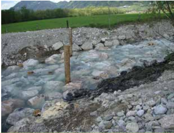
Abb. 9: Einlaufbauwerk des Beckens vor und nach dem Umbau (Steinrampe wurde durch Holzpiloten gesichert)
