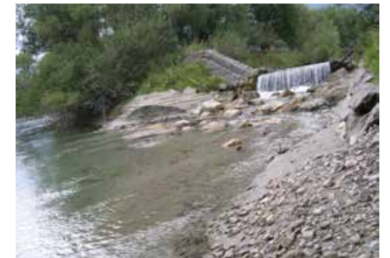
Abb. 7: Mündungsbauwerk vor dem Umbau
