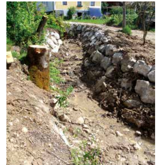
Abb. 11: Einige Impressionen aus der letztlich doch „leergefischten“ Bachstrecke nach dem Umbau. Man erkennt, dass die Steine sehr lückig gelegt wurden, aber zum Ausschwemmen des ungünstigen Feinmaterials wird es noch einige ordentliche Hochwasserdurchläufe brauchen. Fotos: H. Haseke Juni 2018.
