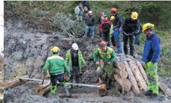
Abb. 5. Bau einer bepflanzten Krainerwand, ingenieurbiologischer Baukurs, Vorarlberg, 2017.
