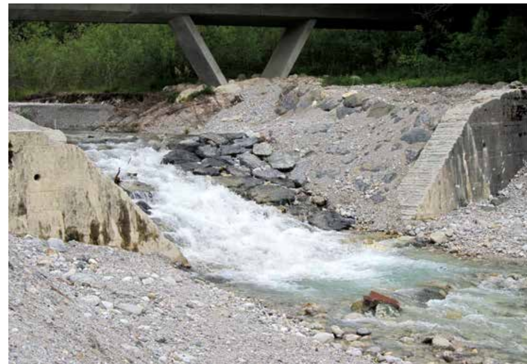
Abb. 2: Rosenbach- Umgestaltung Sperre zu einer Rampe (© G. Kerschbaumer)
