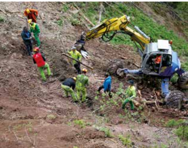
Abb. 4. Bau einer Heckenbuschlage, ingenieurbiologischer Baukurs, Steiermark, 2016 (Foto: Reinhard Ribitsch).
