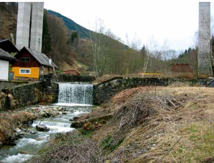
Abb. 5: Sperre am Nöringbach (© Hufnagl, WLV)
