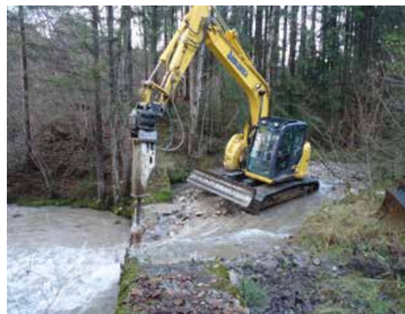
Abb. 15: Schremmen der Schlitzöffnungen (links) und Sicherung durch neue Betonwinkelmauer (rechts)
