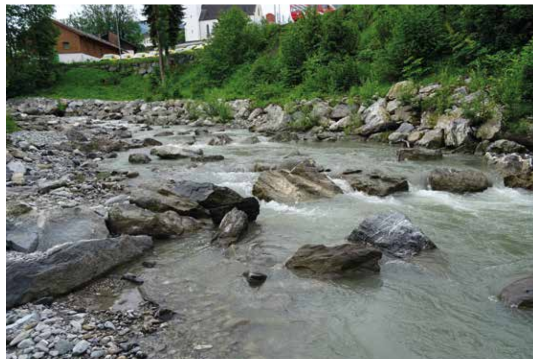
Abb. 6: Bogenförmiger Sohlgurt nach einem Jahr bei mittlerer Wasserführung
