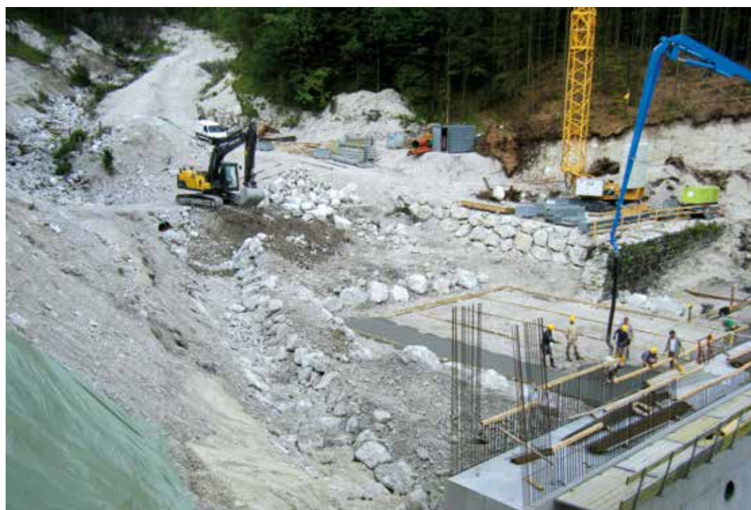
Abb. 5: Links im Bild die Wasserhaltung, in der Bildmitte wird die Sauberkeitsschicht für das Fundament des Sortierrechen errichtet und im Hintergrund befindet sich der Turmdrehkran samt Kranfundament.
