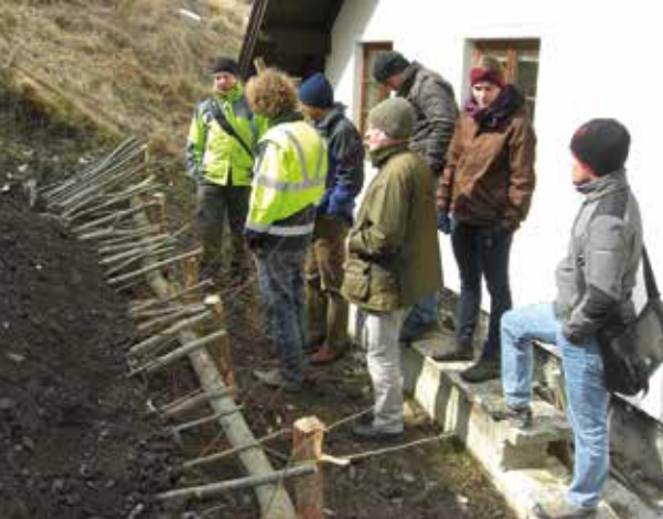
Abb. 3. Bau einer Heckenbuschlage, ingenieurbiologischer Baukurs, Niederösterreich, 2015.
