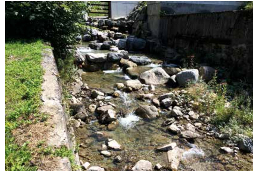
Abb. 4: Pendelrampe statt Absturzbauwerk Steinebach
