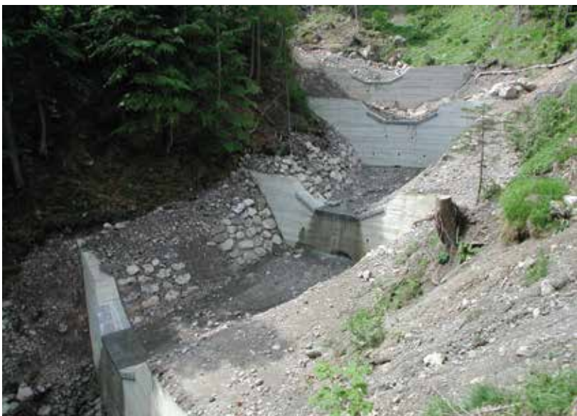
Abb. 3: Errichtete Betonquerbauwerke am Mauerbodenbach aus den Jahren 2006/2007 (Quelle: WLV).
