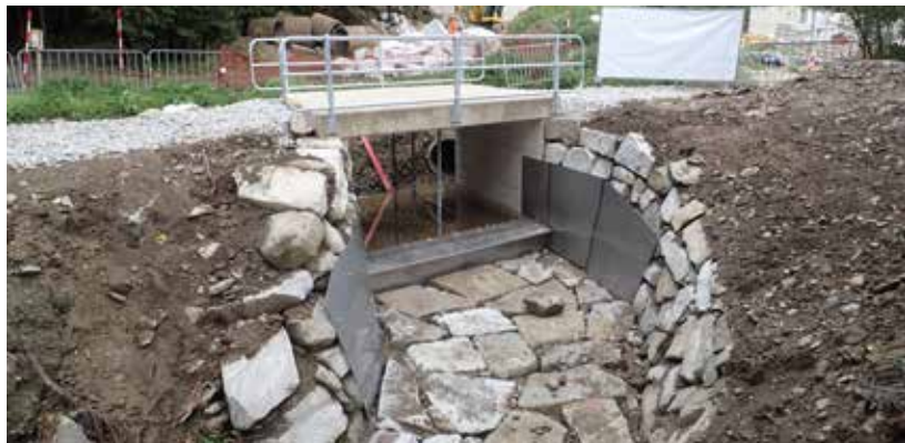
Abb. 6: Die von der WLW fertiggestellte Signalkrebs-Wanderbarriere
