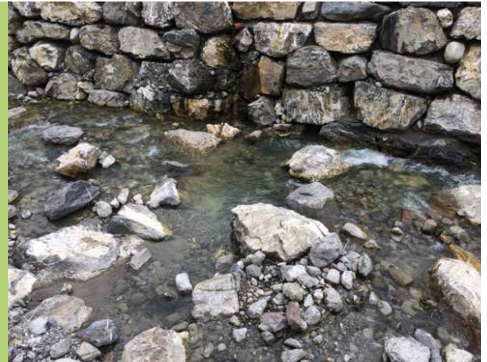
Abb. 14: Detailansicht der sich begrenzt entwickelnden Rampe
