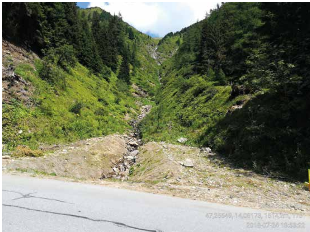
Abb. 9: Schadstelle bei ca. km 33,55 am Ende der zweiten Bauphase; 24.07.2018; diese Fläche wurde bis auf die Weidensteckhölzer bereits im Zuge der Ersten Bauphase im Oktober 2017 fertiggestellt (Foto: C. Schmidt).
