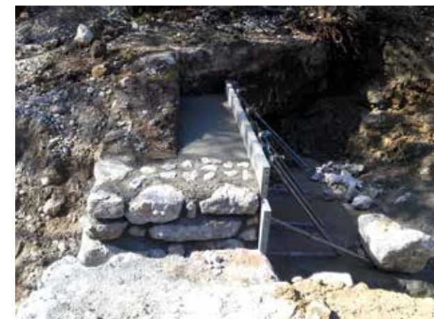
Abb. 15: Schremmen der Schlitzöffnungen (links) und Sicherung durch neue Betonwinkelmauer (rechts)
