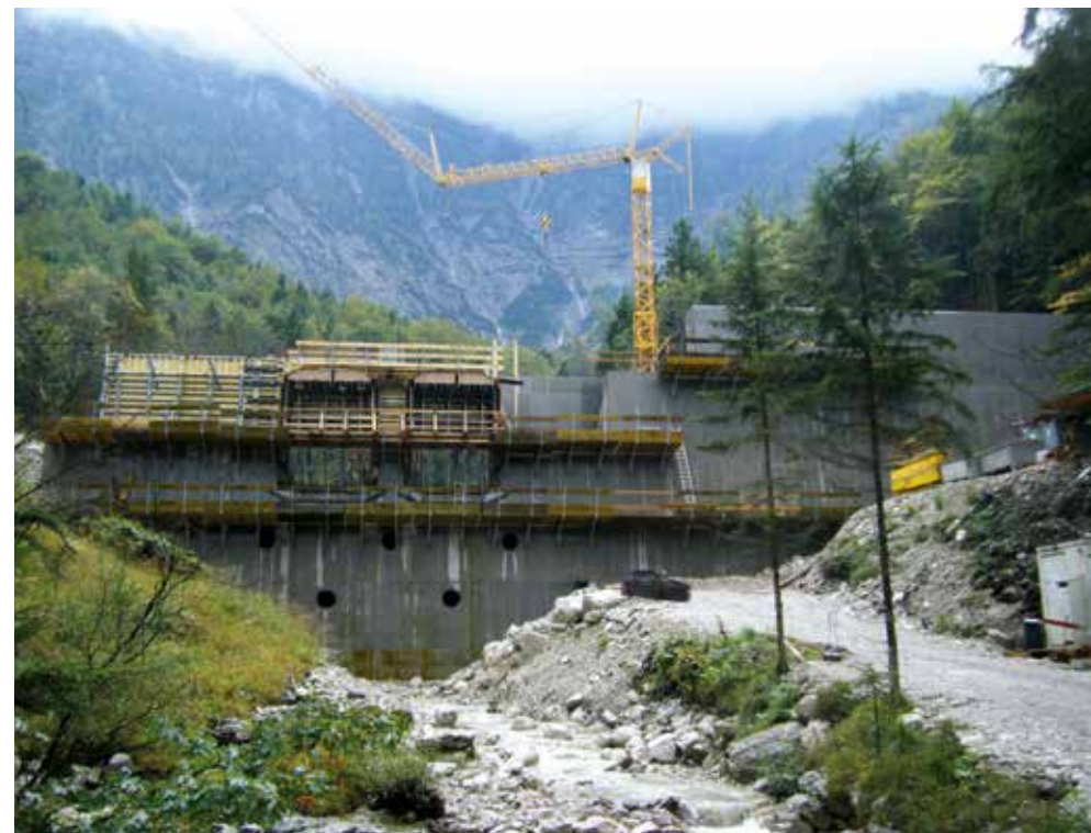
Abb. 6: Filterbauwerk während der Bauphase
