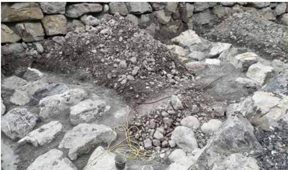
Abb. 12: Sohlgurte in Beton verlegt.
