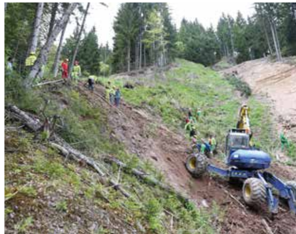
Abb. 4. Bau einer Heckenbuschlage, ingenieurbiologischer Baukurs, Steiermark, 2016 (Foto: Reinhard Ribitsch).
