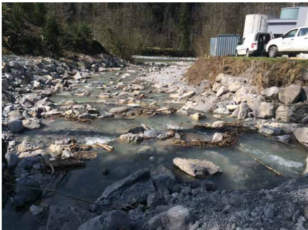
Abb. 4: Fertig gestellte Rampe (<5 %) kurz vor der Einmündung in die Bregenzerach, nach der ersten kleineren Bewehrungsprobe, die bogenartige Ausgestaltung der Sohlgurte ist erkennbar.
