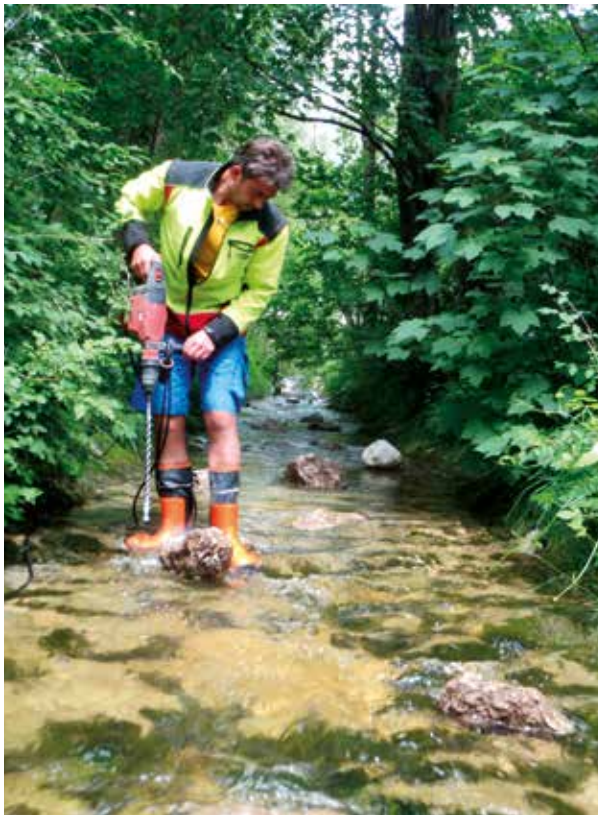
Abb. 6: Die untere Rödtschitzbach-Strecke ist als glatter, gepflasterter Steinkanal ausgebaut. Die Strecke ist für stärkere Steinkrebse mit Mühe durchwanderbar, bietet jedoch auf weite Strecken weder Rastpunkte noch Unterschlupf. Daher schien es wichtig, zunächst einmal Ruhepunkte durch Verankern von Steinen und Ästen zu schaffen. Fotos: H. Haseke
