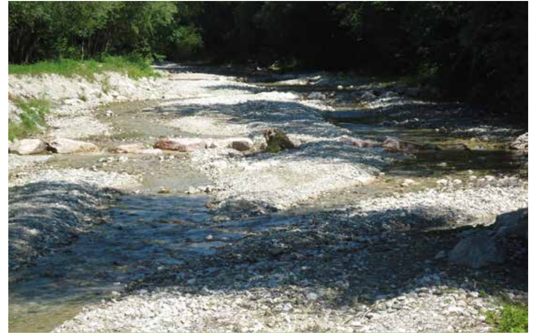
Abb. 11: Durch die Absenkung notwendige Sohlsicherung nach der bewehrten Bautype am Johnsbach (Abbildung 2), die eine optimale Geschiebeumlagerung und Durchgängigkeit gewährleistet
