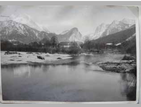
Abb. 10: Mündungsbereich 1952 und vor Baubeginn
