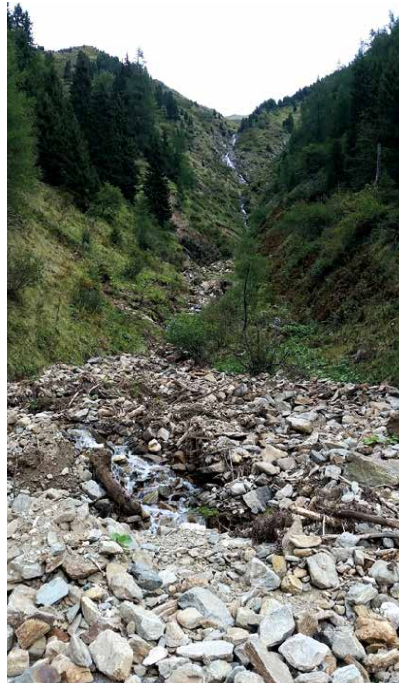
Abb. 8: Schadstelle bei ca. km 33,55 etwa einen Monat nach den Unwetterereignissen; 06.09.2017 (Foto: C. Schmidt).
