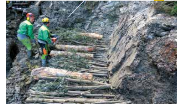
Abb. 5. Bau einer bepflanzten Krainerwand, ingenieurbiologischer Baukurs, Vorarlberg, 2017.
