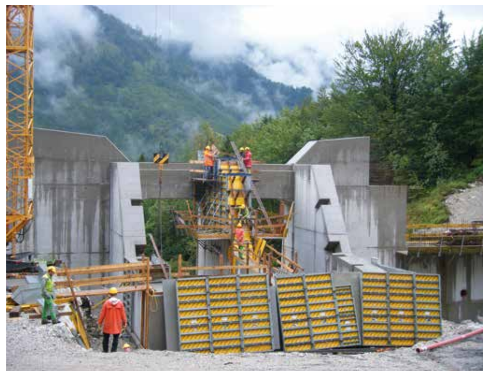
Abb. 7: Errichtung der Wangen für den Sortierrechen
