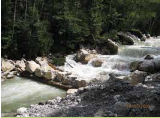
Abb. 3: Ausgleich des Längsgefälles durch Steingurte in Beton verlegt
