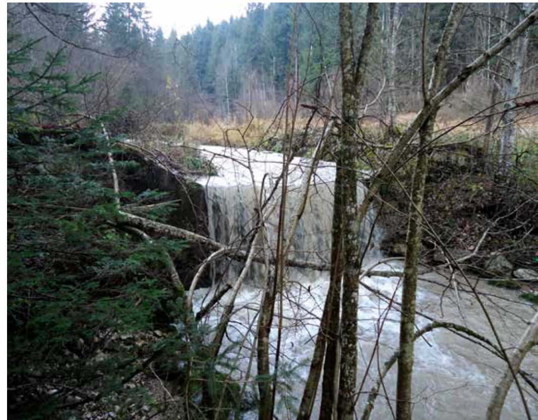
Abb. 14: Sperren aus den 50er Jahren als Barrieren für die Durchgängigkeit
